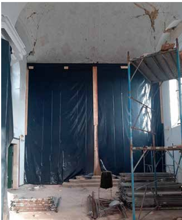
14 Pokupsko, župna crkva Uznesenja BDM/sv. Ladislava, zaštita glavnog oltara (foto: Sabina Obrst Krilić, 2021.)
