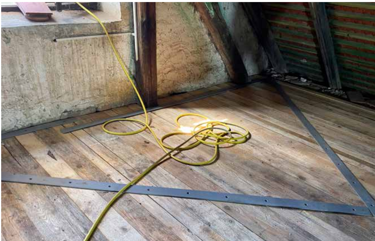
10 Lužnica, dvorac, podna konstrukcija potkrovlja povezana sa zabatnim zidom (foto: V. Jakaša Borić, KO ZG, 2022.) Lužnica, castle, attic floor structure connected to the gable wall (photo: V. Jakaša Borić, Zagreb Conservation Department, 2022)
