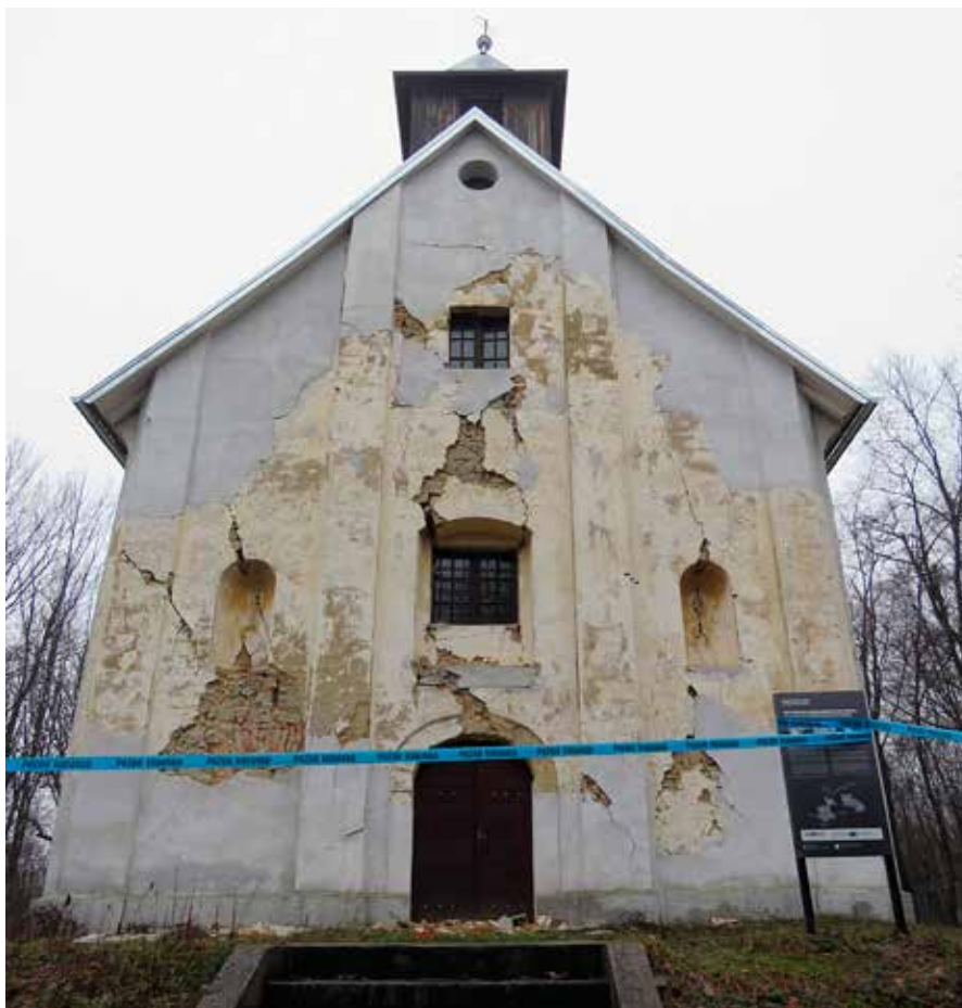
5 Podgorje Jamničko, kapela sv. Vida, oštećenja na pročelju crkve (foto: M. Ožanić, KO ZG, 2021.)
