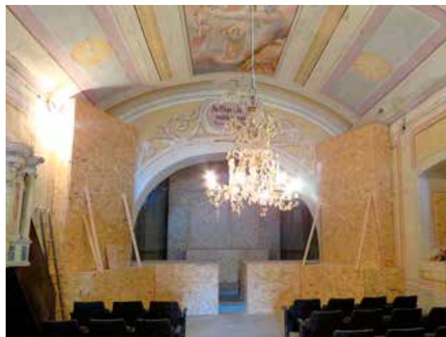
11 Crkva sv. Filipa i Jakova u Reštovu, provedene hitne mjere uz zaštitu inventara (foto: S. Kočevar, KO KA, 2022.)
