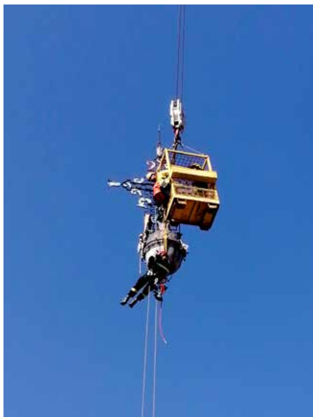
2 Crkva Presvetog Trojstva s franjevačkim samostanom u Karlovcu, skidanje križa i jabuke s vrha zvonika (foto: S. Kočevar, KO KA, 2021.)
