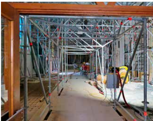
1 Crkva Presvetog Trojstva s franjevačkim samostanom u Karlovcu, teška skela u lađi crkve (foto: S. Kočevar, konzervatorski odjel u Karlovcu - dalje KO KA, 2021.)
