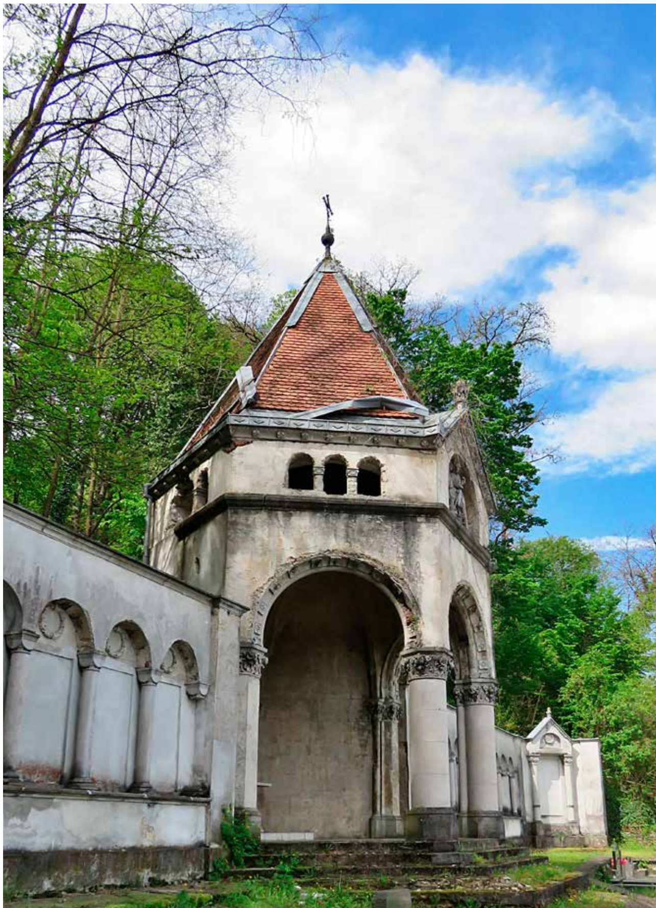
9 Spomenik Glorijeta na Vojnom groblju Dubovac, oštećenja pokrova i limarije (foto: S. Kočevar, KO KA, 2021.)
