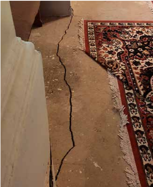
7 Kapela sv. Petra u Gornjoj Stranici, uzdužne pukotine u podu lađe (foto: B. Križanić, KO KA, 2021.)
