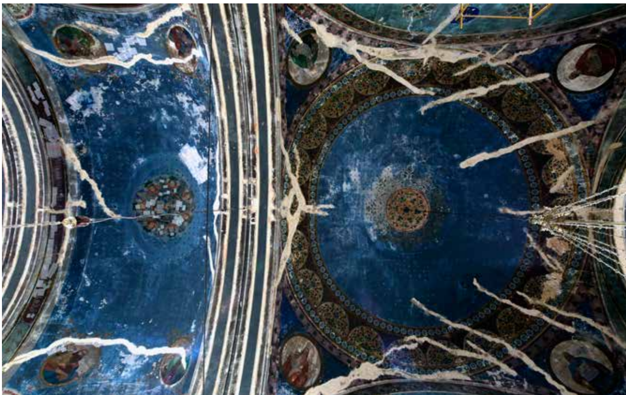
1 Bjelovar, crkva sv. Trojice, svodovi nakon hitnih mjera zaštite (foto: G. Bekina, Konzervatorski odjel u Bjelovaru - dalje KO BJ, 2023.) Bjelovar, Church of St. Trinity, view of the vaults after emergency protection measures (photo: G. Bekina, Conservation Department Bjelovar, 2023)
