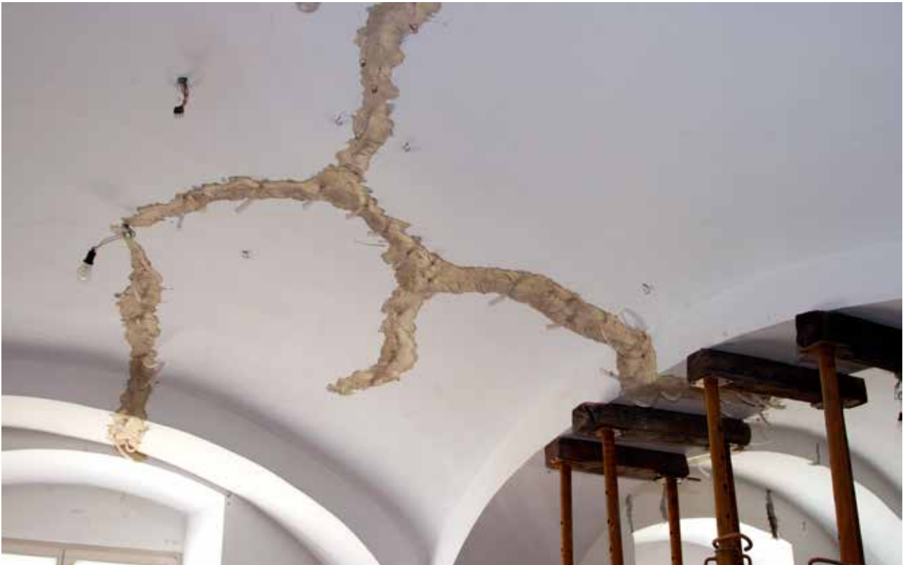
2 Bjelovar, Oberlieutenantes Quartier , injektiranje pukotina svoda (foto: M. Pezelj, KO BJ, 2021.)
