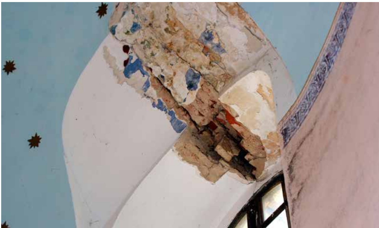
5 Severin, crkva sv. Petra i Pavla, oštećenje prozorskog nadvoja svetišta (foto: M. Pezelj, KO BJ, 2021.)
