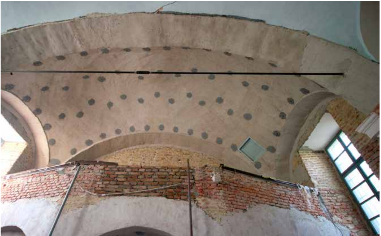
14 Gušćerovec, crkva sv. Antuna i ostaci kaštela, konstrukcijsko ojačanje svodnog polja kora (foto: M. Pezelj, KO BJ, 2021.)
