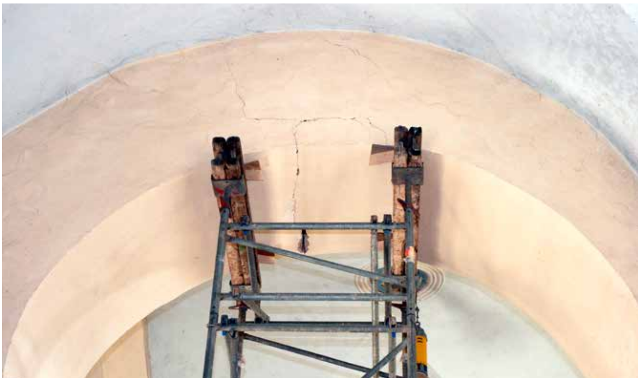
3 Čazma, crkva sv. Marije Magdalene, pojasni luk južnog broda nakon podupiranja (foto: M. Pezelj, KO BJ, 2021.)
