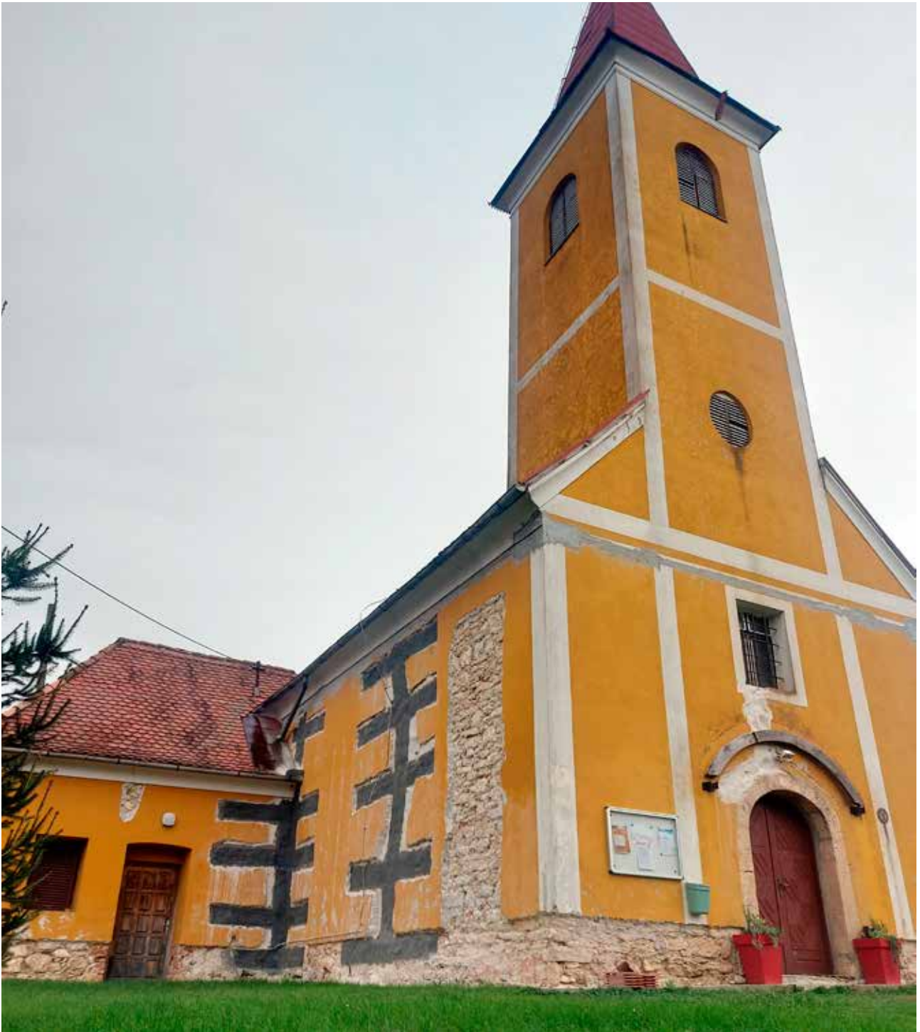
1 Jakopovec, kapela sv. Jakova, sanacija oštećenja nastalih u potresu primjenom FRCM i FRP sustava (foto: V. Pascuttini-Juraga, Konzervatorski odjel u Varaždinu - dalje KO VŽ, 2023.)
