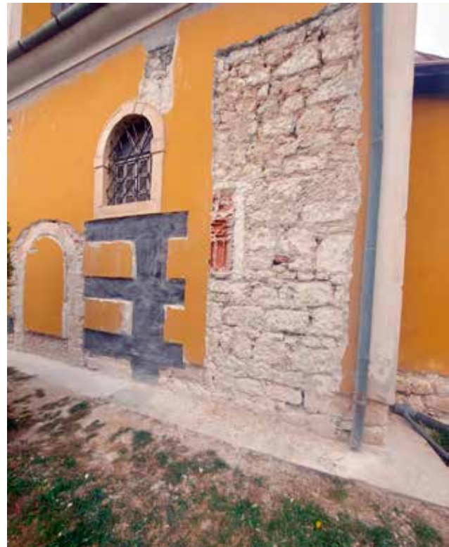
2 Jakopovec, kapela sv. Jakova, tijekom sanacija oštećenja na pročeljima otkriveni su povijesni prozori i vrata (foto: V. Pascuttini-Juraga, KO VŽ, 2023.)
