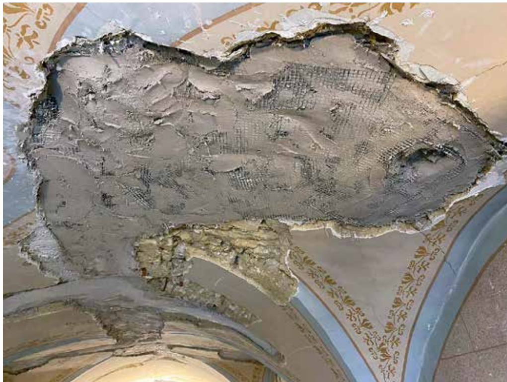
5 Maruševec, crkva sv. Jurja mč., sanacija oštećenja primjenom FRCM sustava (foto: V. Pascuttini-Juraga, KO VŽ, 2021.)
