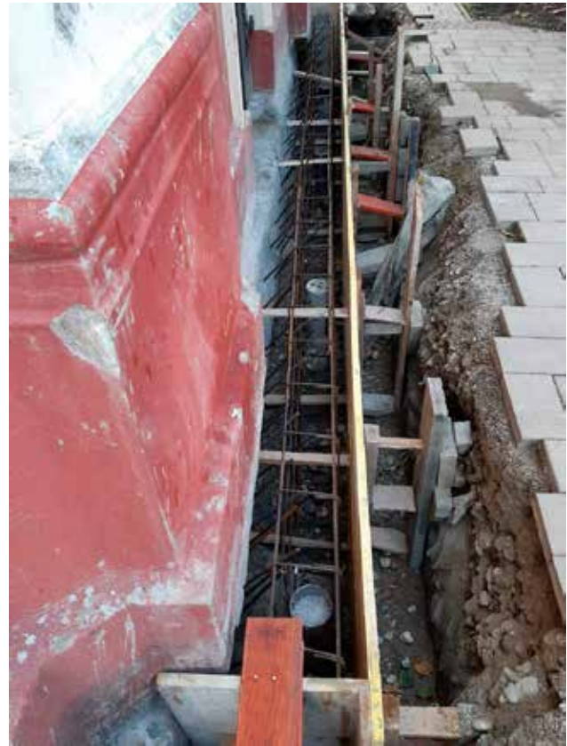
4 Draškovec, crkva sv. Roka, izvedba pilota (foto: I. Peharda KO VŽ, 2021.)
