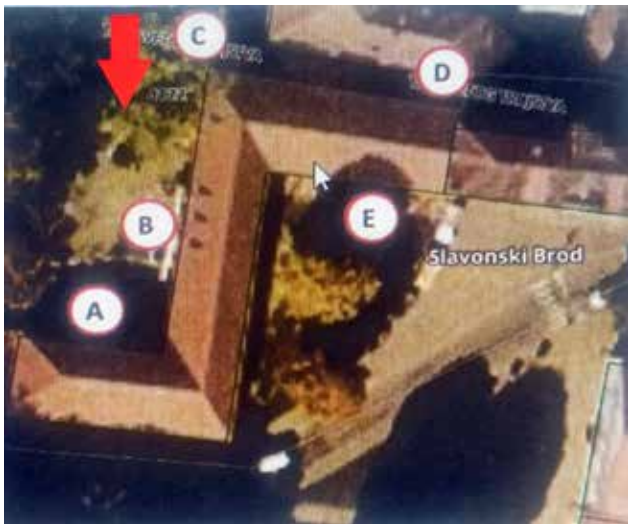
9 Zgrada gradskog magistrata u Slavonskom Brodu – oštećenja (Ingri d.o.o., Ruščica 2021.)
