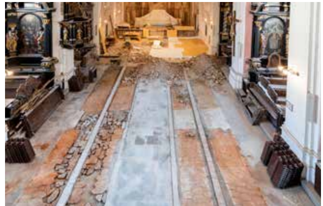
11 Pločenje od heksagonalnih tavela ispod klupa u lađi crkve, stanje 2022. (foto: K. Gavrilica, HRZ, 2022.)
