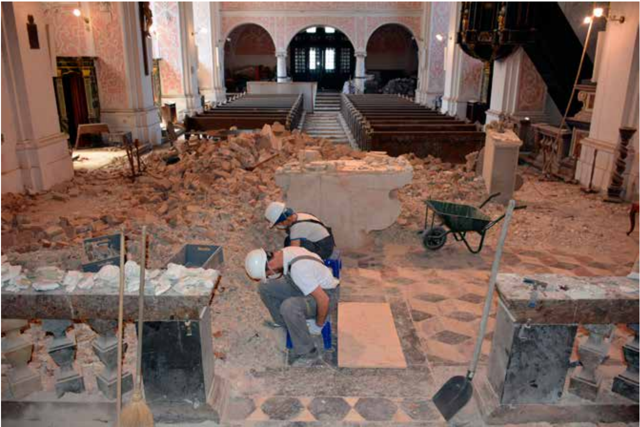
6 Prikupljanje fragmenata građe urušenog svoda, 2022. (foto: M. Jelenčić, HRZ, 2022.)
