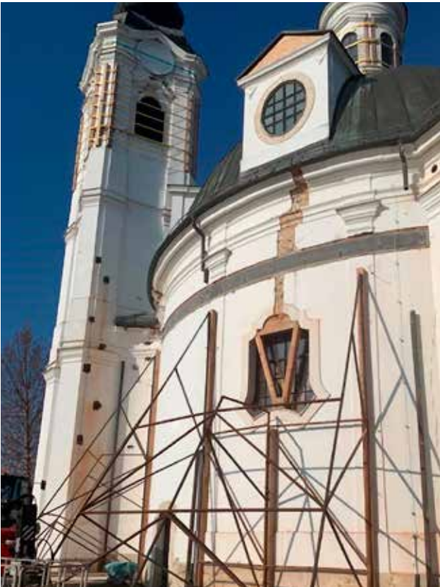
8 Crkva sv. Marije Magdalene u Selima, izvedene mjere privremene zaštite i stabilizacije – ugrađena sidra u zidovima zvonika i nad trijumfalnim lukom, karbonska traka u vrhu zidova i uklonjeni i privremeno zatvoreni zabat krovnih kućica na kupoli (foto: M. Vujasinović, Intrados projekt d.o.o., 2022.)
