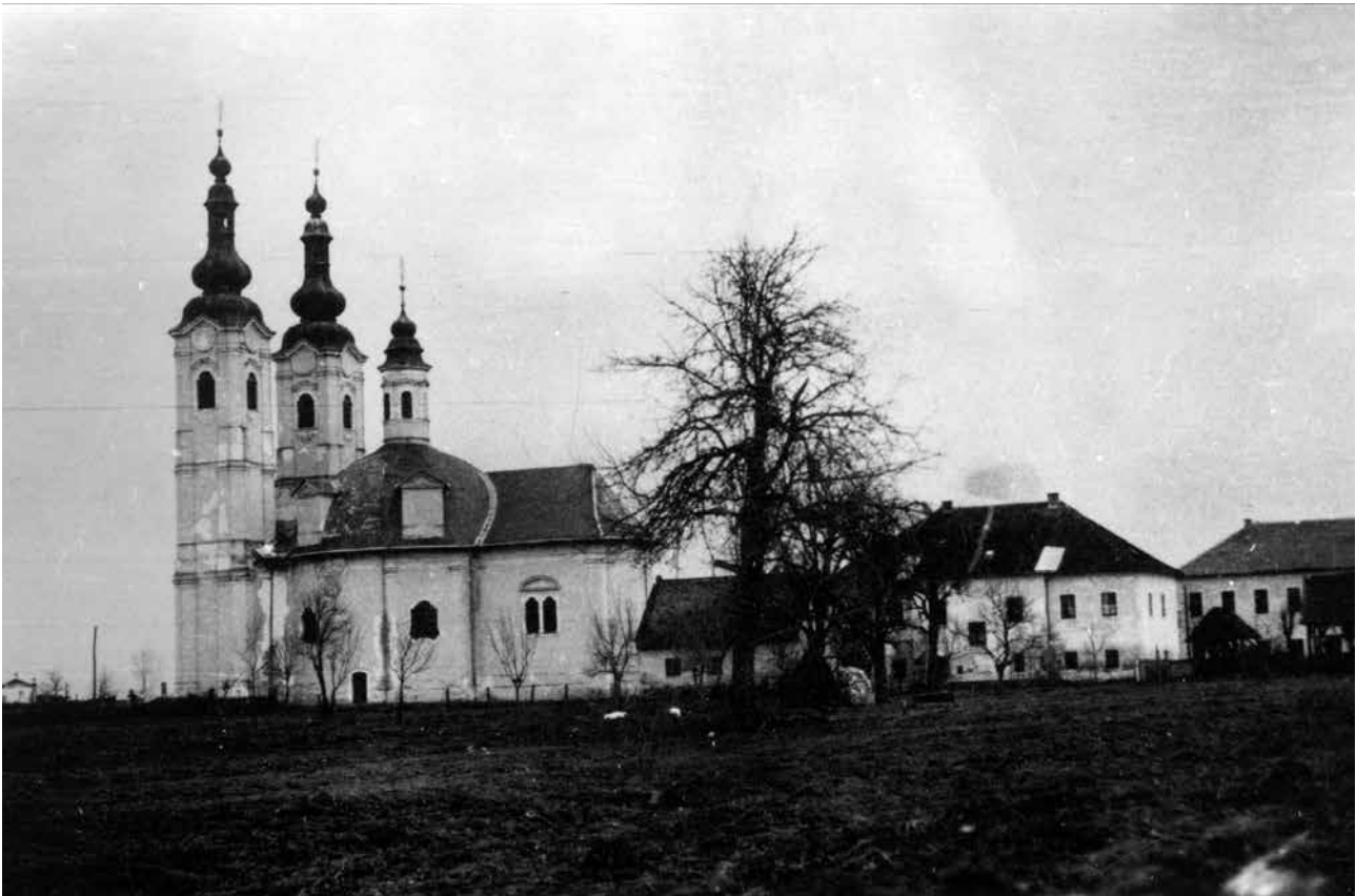
1 Sela, pogled na južno pročelje crkve sv. Marije Magdalene i zgradu župnog dvora (MKM, UAKM – FKB, inv. br. 55153, 1951.)
