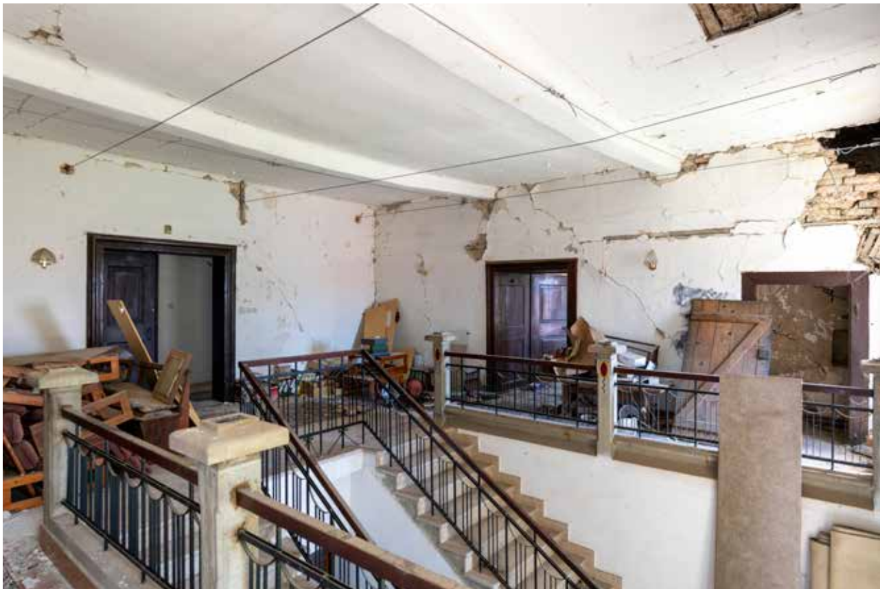
13 Župni dvor u Selima, unutrašnjost – stanje nakon potresa (foto: LJ. Gamulin, fototeka HRZ, 2022.)
