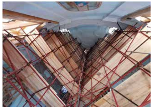
9. Crkva sv. Marije Magdalene u Selima, izvedene mjere privremene zaštite i stabilizacije – poduporna skela u lađi (foto: M. Vujasinović, Intrados projekt d.o.o., 2022.)
