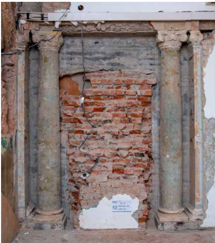
12 Zgrada na Griču 3, stupovi od štuko-mramora pronađeni sondom u zidu jedne sobe (foto: J. Kliska, HRZ, 2020.)
