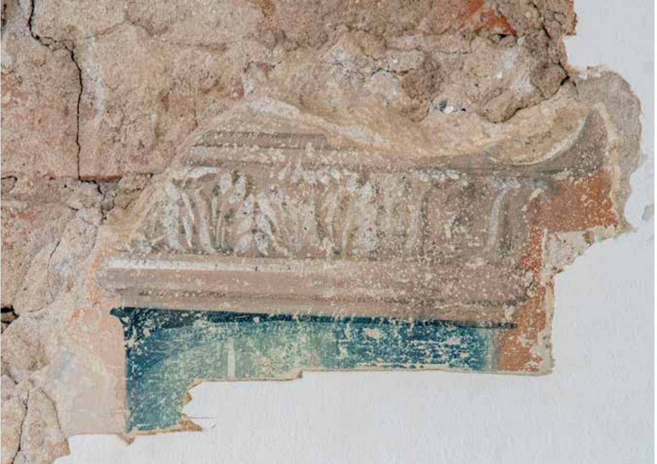
11 Zgrada na Griču 3, zidni oslik pronađen sondom u središnjem salonu s iluzionističkim prikazom arhitekture, detalj kapitela stupa (foto: J. Kliska, HRZ, 2020.)
