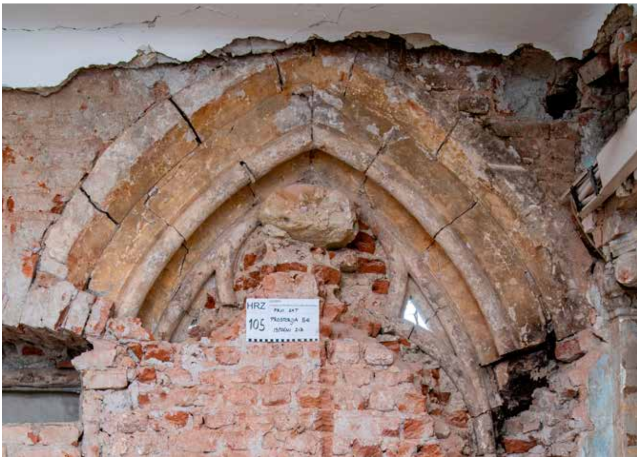
10 Zgrada na Griču 3, srednjovjekovni prozor u istočnom vanjskom zidu (foto: J. Kliska, HRZ, 2020.)
