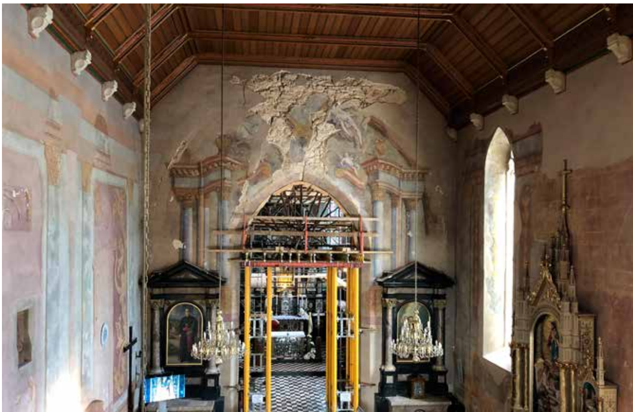
2 Remete, župna crkva Uznesenja Blažene Djevice Marije, primjer hitnih mjera stabilizacije nakon zagrebačkog potresa provedenih uz financijsku pomoć ALIPH-a (foto: V. Bralić, MKM, 2020.)
