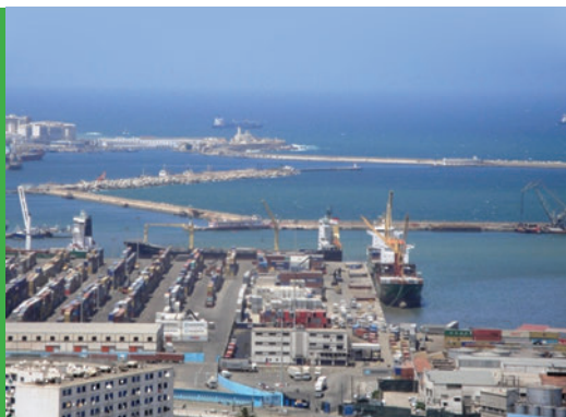
Sl. 13. Kontejnerski terminal u alžirskoj luci
