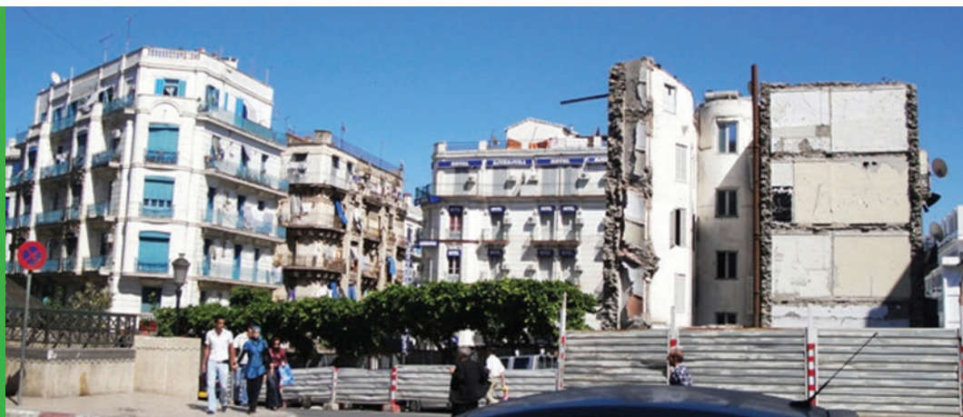
SI. 4. Rušenje zgrada u centru grada
