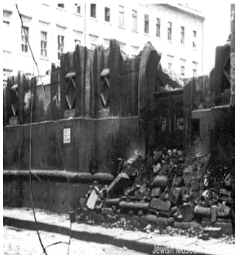
Fotografija 4: Fotografija spaljene i razrušene sinagoge u Brnu. Izvor: The Great Synagogue, https://www.brnotrails.cz/en/object/6-the-great-synagogue (posjet 1. 4. 2023.). Slika je u vlasništvu The Jewish Museum in Prague.
