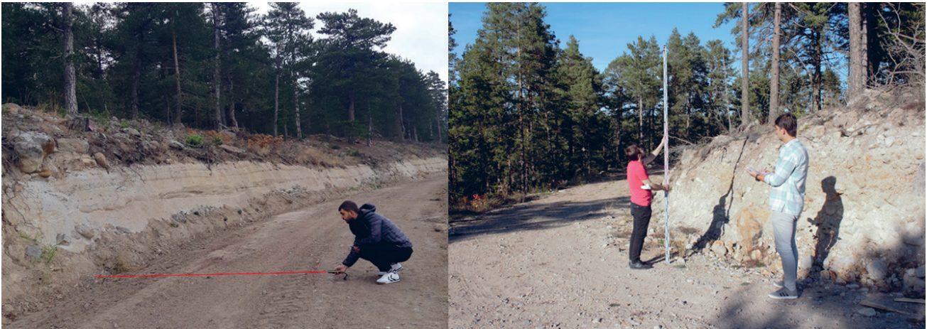
Figure 8. Measurement of cut slope width and height Slika 8. Mjerenje širine i visine usjeka
