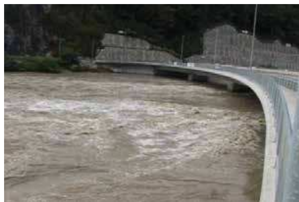
Slika 6: Suženi poprečni profil na Savi uzvodno od NE Krško (foto: Marko Burger, snimljeno 19. rujna 2010.)
