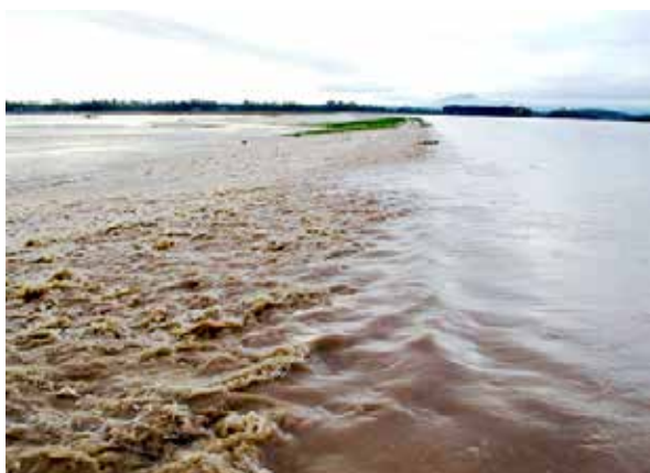
Slika 9: Detalj neznatnog preljevanja na preljevu Jankomir i ulaz u rasteretni kanal Sava- Odra (foto Zlatko Blažević, snimljeno 6. 9. 2012.)
