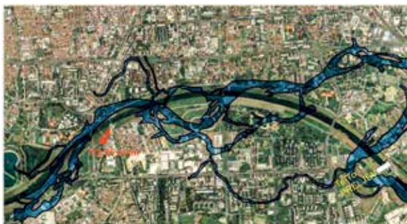
Slika 1: Situacije korita rijeke Save krajem 19. stoljeća (prije početka regulacijskih radova) i današnjeg stanja na užem području grada Zagreba (Slukan Altić, 2010.; Kuspilić i sur. 2020)
