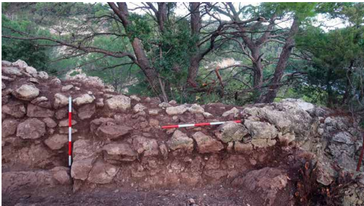
Sl. 7. Temelj stubišta koje je vodilo na bedem Fig. 7 Foundation of the staircase that led onto the rampart
