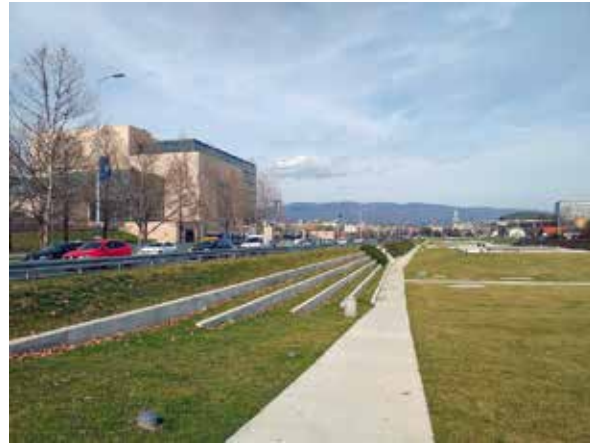
Sl. 29. Zagreb, Južni pristup, sr. 20. st. i kasnije (foto: V. Bedenko)
