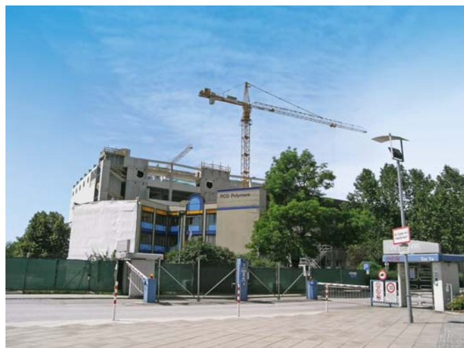
SLIKA 2 - Izgradnja Inovacijskog centra tvrtke Borealis u Linzu (foto: Kunststoff Cluster )
