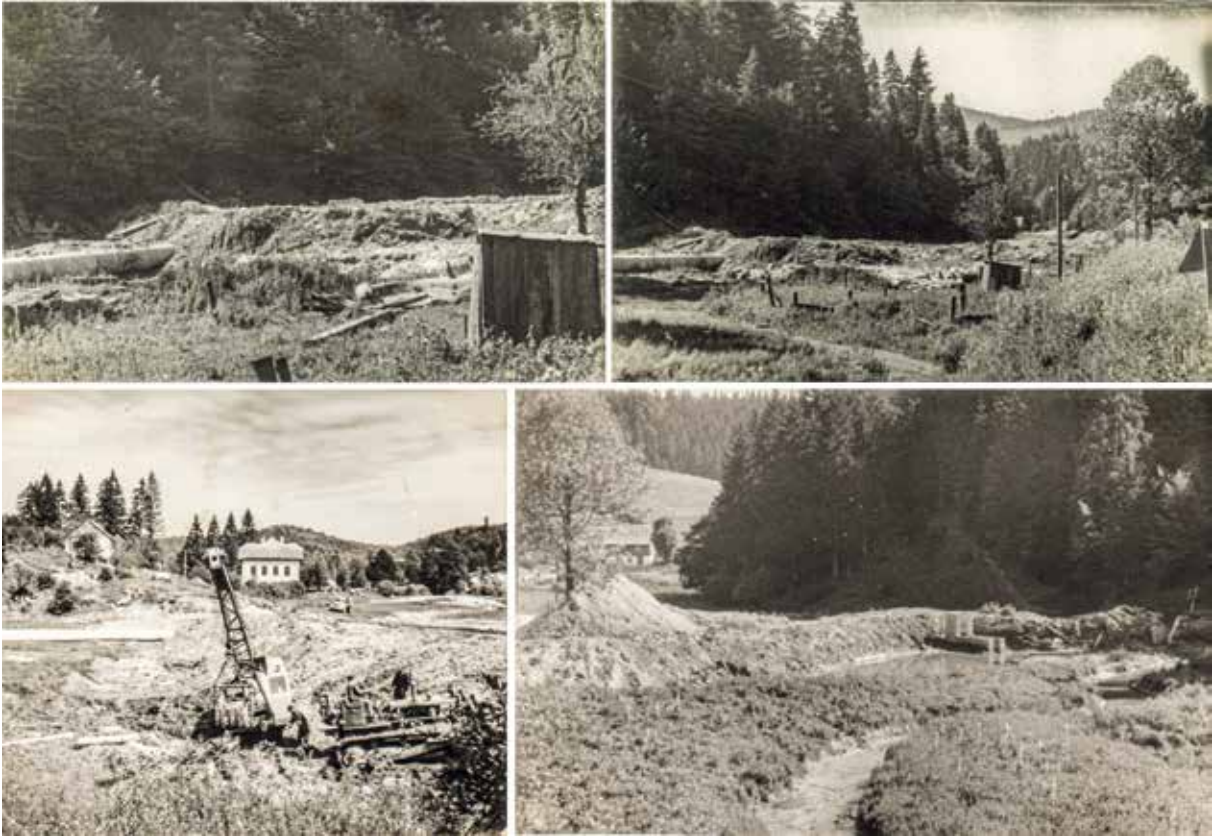
Slika 6: Tijek izgradnje betonske pregrade na Bijeloj rijeci (arhiva NPPJ).
