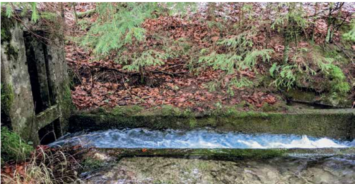
Slika 7: Vanjski dio betonske pregrade u koju utječe tok Bijele rijeke. Vodotok utječe u betonsku ustavu i istječe nakon otprilike 37 m kroz cijev (arhiva NPPJ).
