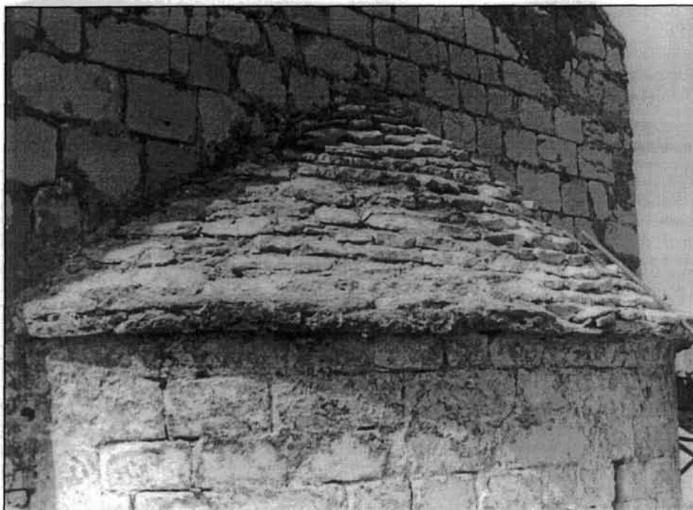
Sl. 8. Pokrov od kamenih ploča nad svetištem crkve sv. Jurja na "Gradini" nakon skidanja cementne glazure postavljene prethodnom obnovom
