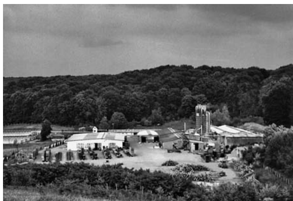
Slika 11. Pogled na jednu privatnu hrvatsku pilanu Figure 11 View on a sawmill in Croatia
