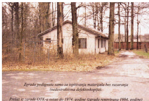
Zgrada podignuta samo za ispitivanja materijala bez razaranja (nedestruktivna defektoskopija). Prelaz iz zgrade OTK-a ostao do 1974. godine (zgrada renovirana 1984. godine) Zgrada podignuta samo za ispitivanja materijala bez razaranja (nedestruktivna defektoskopija). Prijelaz iz zgrade OTK-a ostao je do 1974. godine (zgrada renovirana 1984. godine). Building erected solely for non-destructive material testing (non-destructive testing). The transition from the OTK building remained until 1974 (the building was renovated in 1984).
