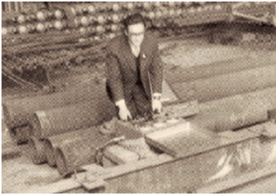
1964.: Sisak, Željezara Sisak – kontrola, kao inženjer za nedestruktivnu defektoskopiju – rukovanje ro uređajima 1964: Sisak, Sisak Ironworks - Inspection, as a non-destructive testing engineer - operation of X-ray devices
