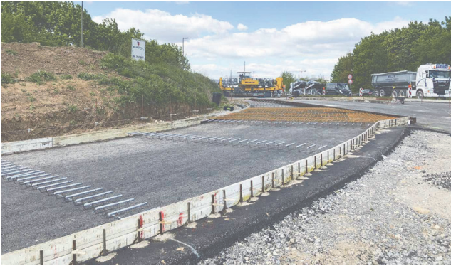
Slika 7. Priprema betonskog sloja s ojačanim, geometrijski kritičnim područjem; prethodno postavljanje moždanika u košare ispod naknadno izvedenog poprečnog spoja [3]
