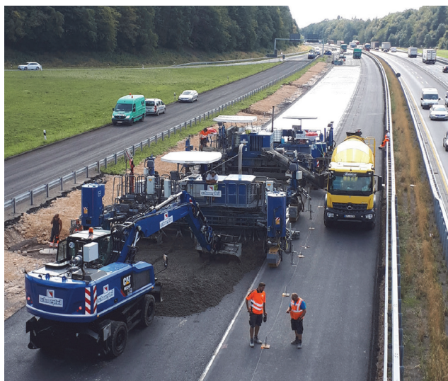
Slika 17. Horizontalna hibridna metoda gradnje za obnovu prometne autoceste A61, Njemačka [7]
