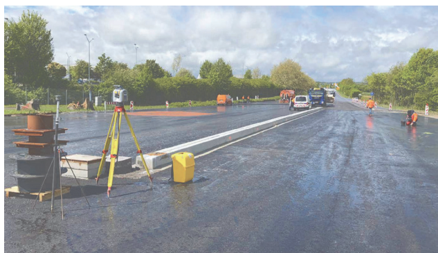
Slika 6. Raskrižje tijekom ugradnje betonskog kolnika: asfaltni nosivi sloj raskrižja Daimler [3]
