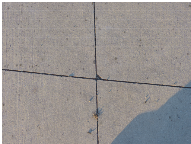
Slika 2. Površina betonske kolničke konstrukcije ne omogućava nastajanje kolotruga s visokom akumulacijom vode [autor, 2016.]
