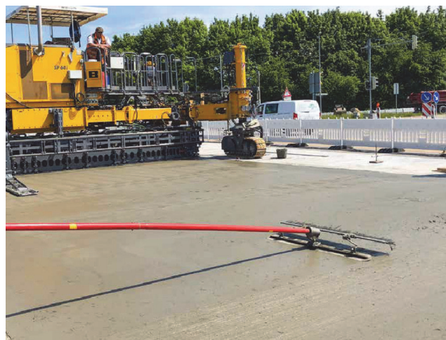
Slika 13. Završna obrada površine betonskog kolnika pomoću metle [3]
