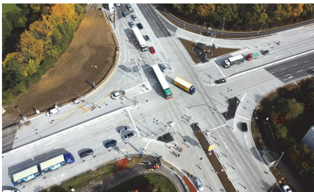
Slika 3. Raskrižje tijekom izvedbe betonskog kolnika: raskrižje Daimler, okrug Böblingen [3]
