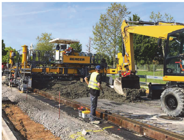
Slika 12. Precizna metoda gradnje betonskog kolnika pomoću finišera [3]
