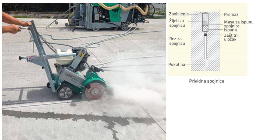
Slika 14. Rezanje prividnih spojeva: u prvom planu je glodanje reza (zaobljenje), u pozadini, stroj za rezanje s prethodno izvedenim prvim te izvođenje drugog spoja (prvo se izvodi "zarezi" spoja, slijedi proširivanje razmaka spoja); poprečni presjek prividnog spoja [3]
