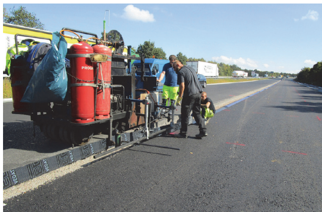
Slika 22. Precizno lijepljenje bitumenske folije na rub asfalta [7]
