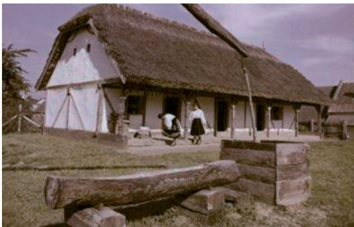
4. Abbildung: Zerrbalkenhaus (Talpasház) in Sellye
