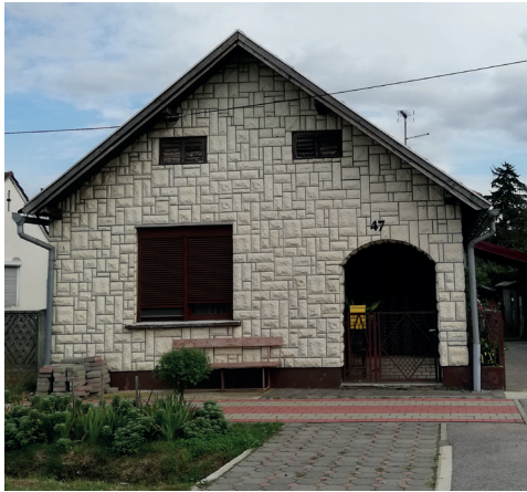
Sl. 6. Primjer obnove zidanice s novim materijalom, Gajeva ulica, Hlebine (snimila Patricija Andrašić, 26. 9. 2022.).
