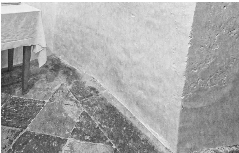
Sl. 13. Spoj stare sakristije i svetišta
