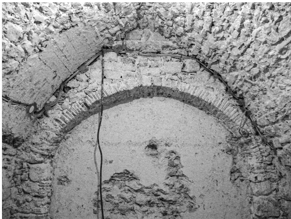
Sl. 11. Sjeverni dio stare sakristije u vrijeme obnove (gore lijevo vidi se zazidan nekadašnji prolaz prema propovjedaonici)
