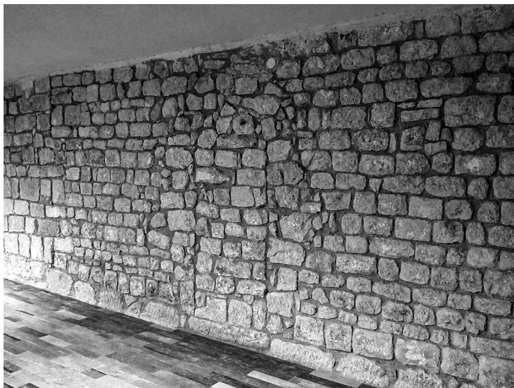
Sl. 2. Zazidana bočna vrata i istočni dio srednjovjekovnog zida
