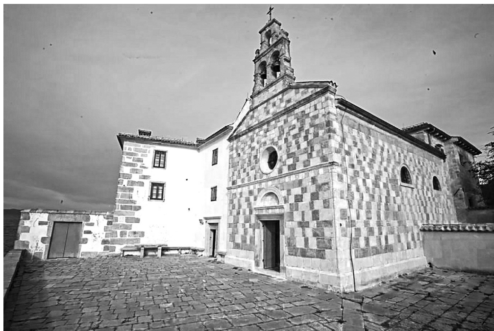
Sl. 33. Nakon obnove (foto: Damir Krizmanić)
