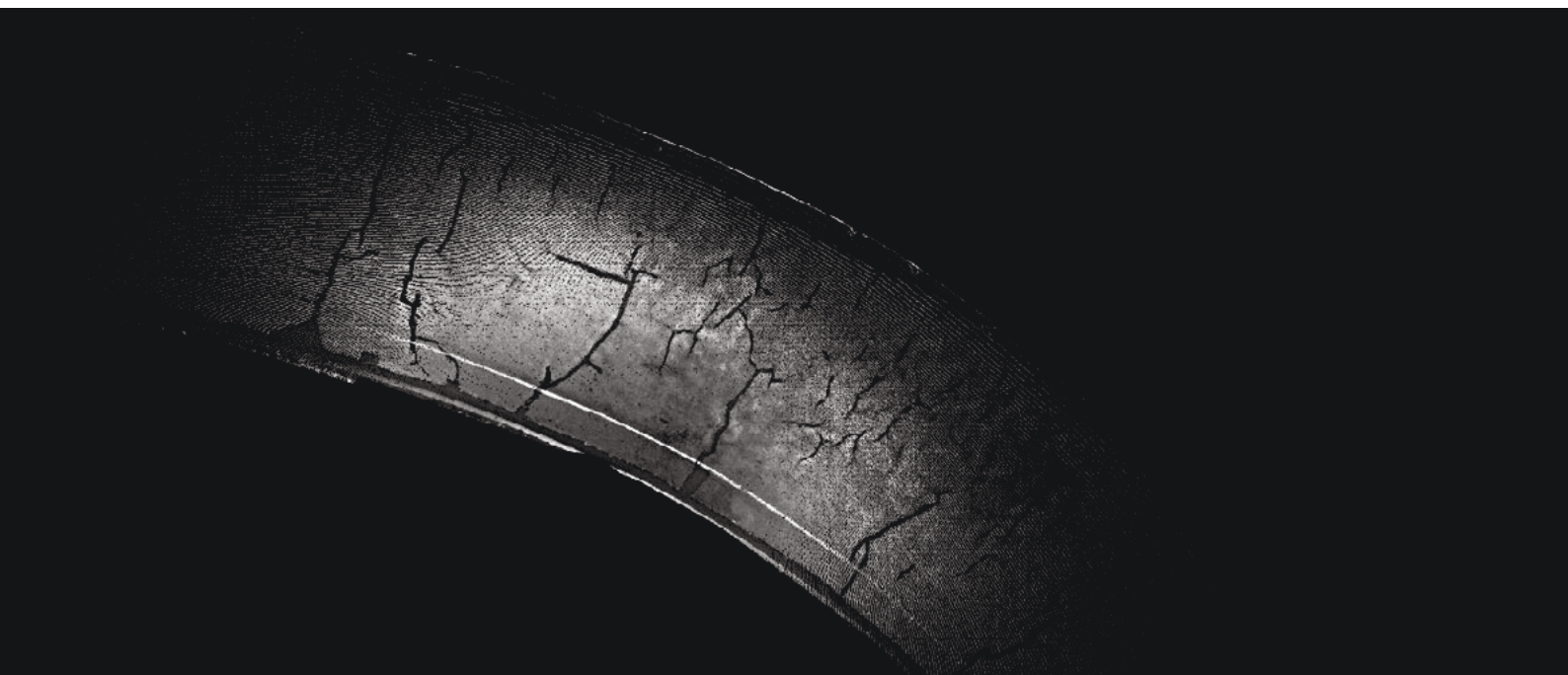
Slika 12. Prikaz oštećenosti dijela Velodroma u programu CloudCompare.
