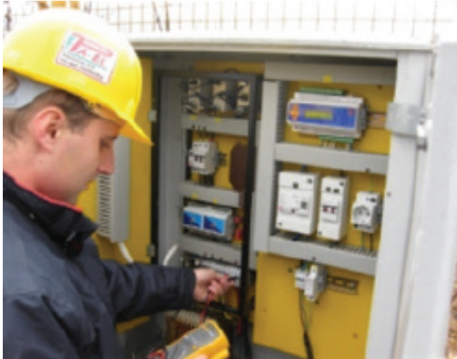
Slike 6. i 7. Periodička mjerenja i ispitivanja na sustavu katodne zaštite
