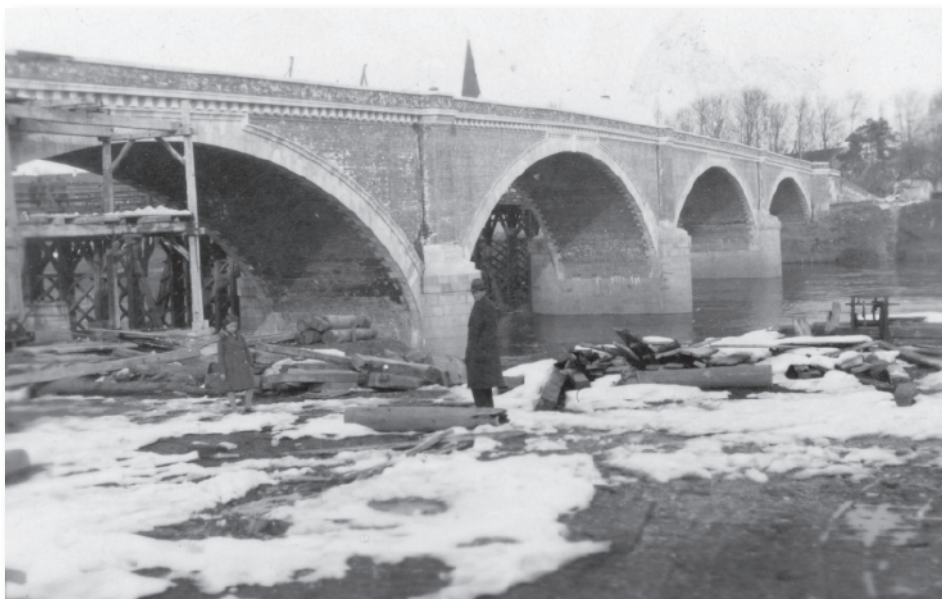
HR-DASK-831.1.1.3. Stari (zidani) most na Kupi u gradnji, u pozadini vidljiv stari drveni most preko Kupe; 1932.
