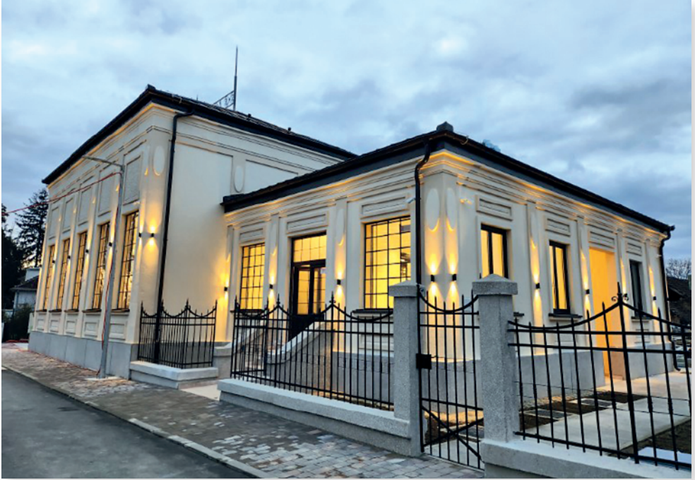
https://mipro.hr/referentna-lista/gradska-munjara-petrinja-110/ , preuzeto 2. 8. 2024. Fotografija novoobnovljene zgrade električne centrale u Petrinji.
