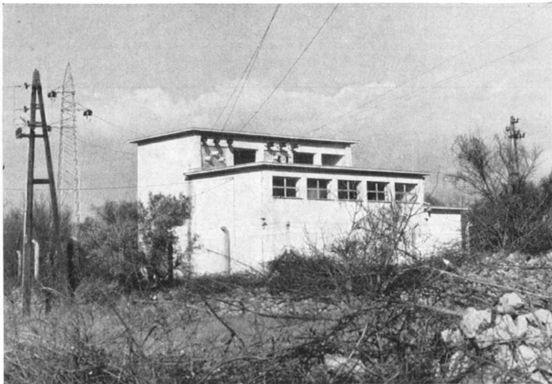
Glavna trafostanica kod Sv. Vida
