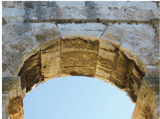
Sl. 19 Luk između pilona 17 i 18. Primjer rekonstrukcije luka tijekom kampanja s kraja 19. stoljeća (fotografija: Đ. Gobić-Bravar).
