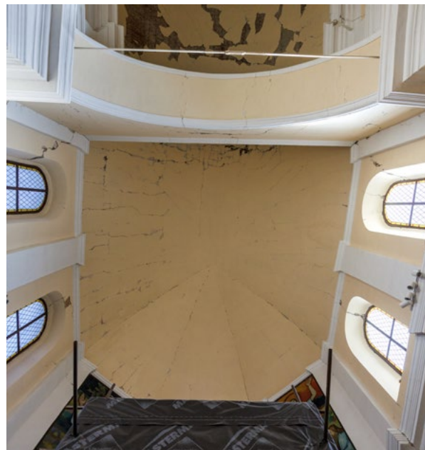
14. Drveni svod u svetištu izveden 1906. (snimka: P. Mofardin, 2023.) Wooden vault in the sanctuary built in 1906 (P. Mofardin, 2023)
