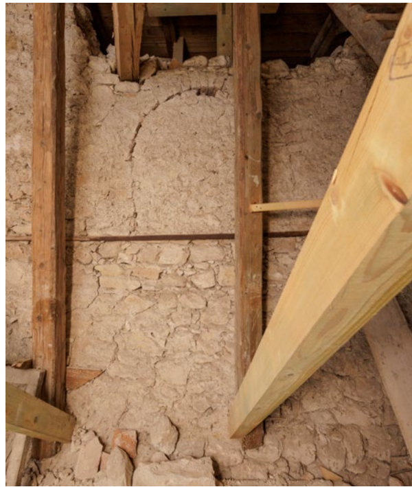
6. Zazidani bazilikalni prozor vidljiv iz potkrovlja (snimka: P. Mofardin, 2023.) Bricked-up window of the basilica visible from the attic (P. Mofardin, 2023)
