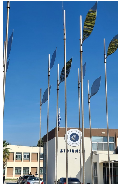
Slika 2. – Upravna zgrada u Sindosu
