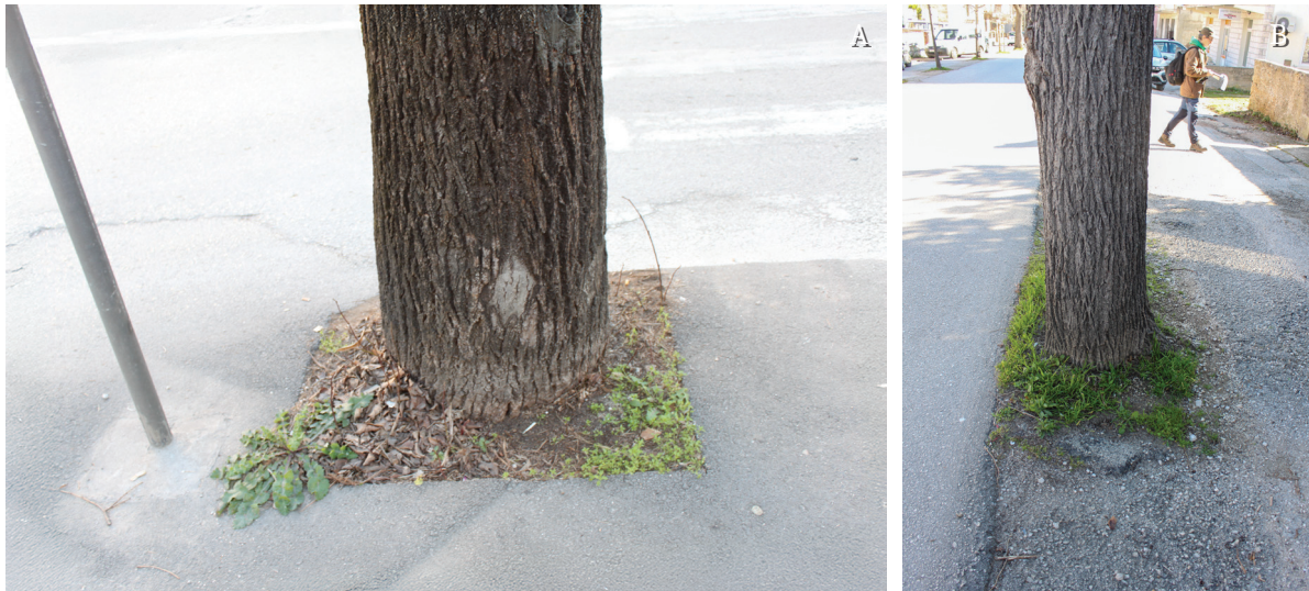
Slika 5. Asfaltiranje oko debla lipovih stabala u aleji „Zlinje“ (A, B).
