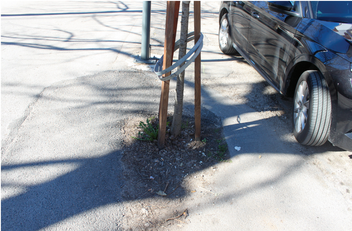
Slika 7. Nedostatna zaštita debla od mehaničkih oštećenja.
