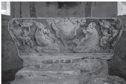
Sl. 10. Zidana menza glavnog oltara nakon preliminarnih zahvata, stanje godine 2011. Fototeka HRZ, Odjel za zidno slikarstvo i mozaik.
