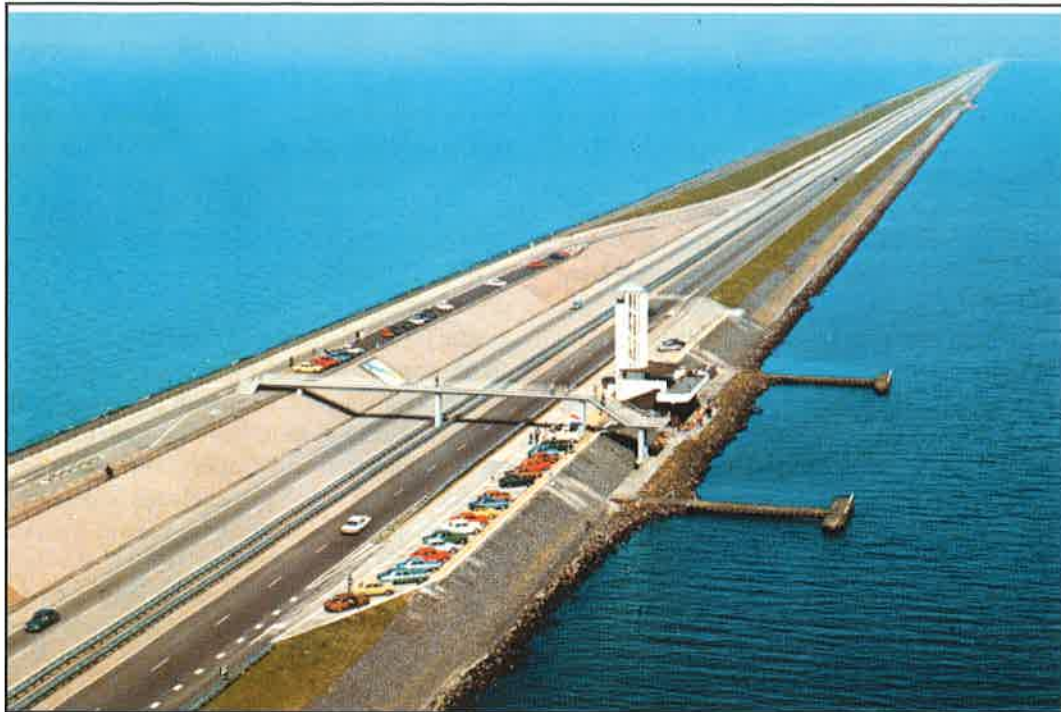
Sl. 1. Monumentalni, 30 km dug nasip Afsluitdijk, izgrađen u razdoblju 1920. - 1932. koji zatvara prostrani i u kopno duboko uvučen zaljev Ijsselmeer. U prednjem planu vidikovac s parkiralištem i cesta što povezuje nizozemsku regiju jezgre Randstat Holland, na jugu, s pokrajinom Friesland, na sjeveru
