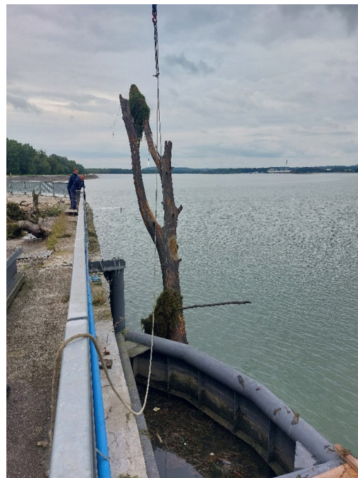
Slika 4. Vađenje naplavina ispred zaustavne stijene Figure 4. Removal of debris in front of the stopping rock
