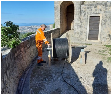
Slika 7. Povlačenje kabela preko nosača i osovine Figure 7 Pulling the cable over the support and shaft
