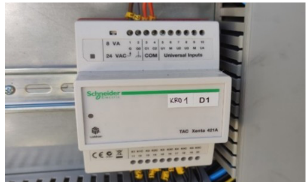
Slika 12. Upravljanje preko grebenastih sklopki na GRMO Figure 12 Control via cam switches on GRMO
