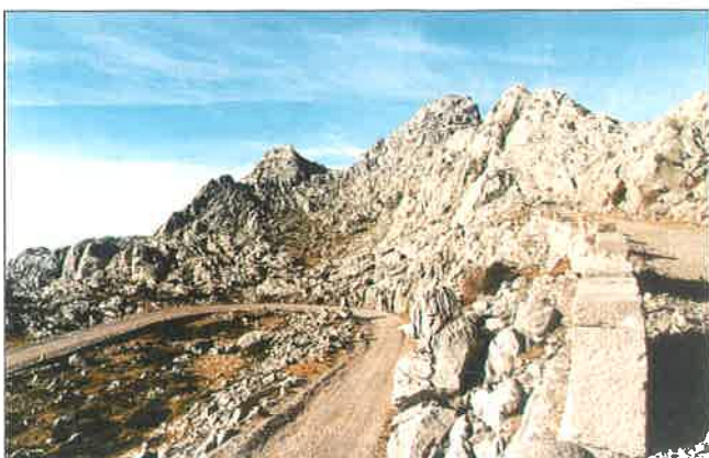
Fot. 2. Zavojnica Majstorske ceste kroz Tulove greda Snimio: Studio HRG
