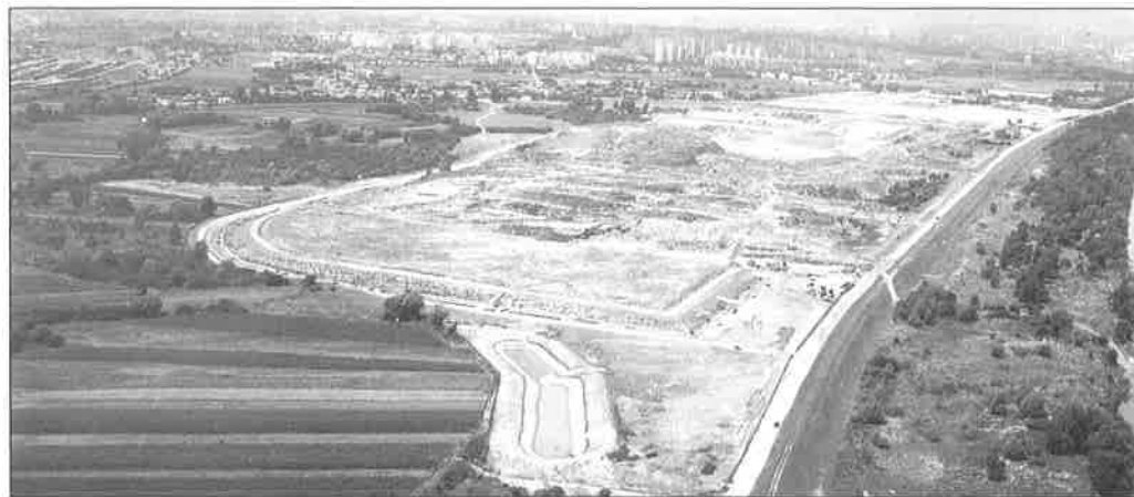
Fot. 2. Sanacija odlagališta otpada "Jakuševac" - 1. faza Snimio: Studio HRG
