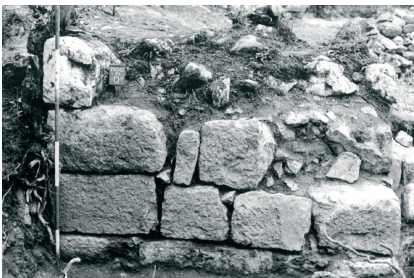
Sl. 4. Mlakvena greda, 1989. romanički slog gradnje (M. Šmalcelj)
