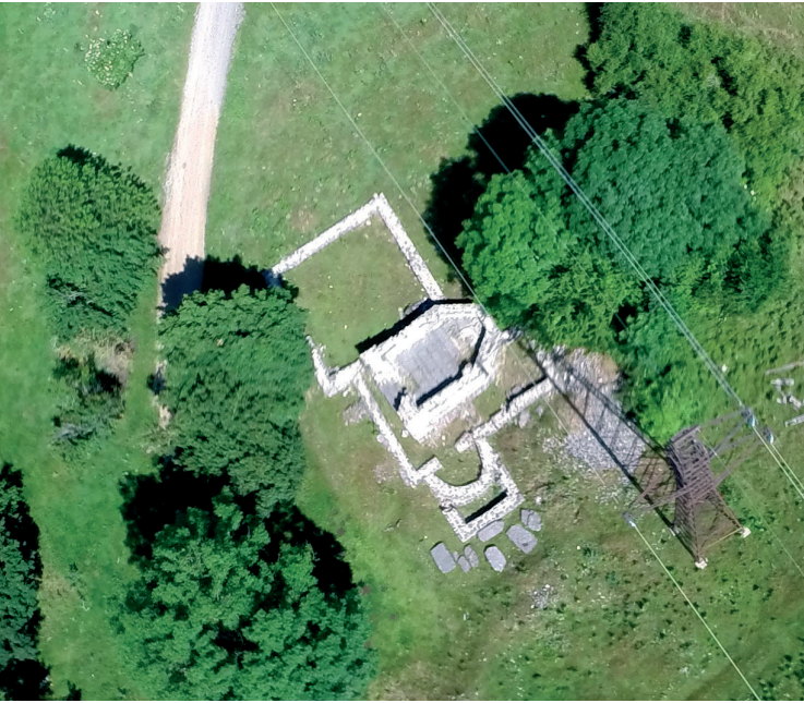
Sl. 9. Podudbina, sv. Marko 2014. (DJI) Fig. 9 Podudbina, St. Mark 2014. (DJI)
