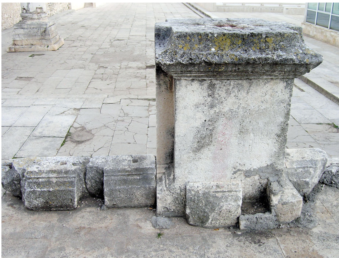
SLIKA 3. Utori za drvene grede na poleđini stubaca i pluteja (foto: D. Maršić)
