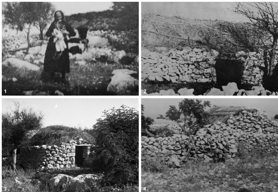
Slika 8. Primjeri stočarskih građevina pokrivenih vegetativnim materijalima: Dugi otok – Čuh (OŠTRIĆ 1993: T. XIII/2), Pag (PALČIĆ 1972: 46), 3. Dugi otok - Sali (BATOVIĆ 1973: T. LXII), 4. Povljana (TIČIĆ 2021: 95).
