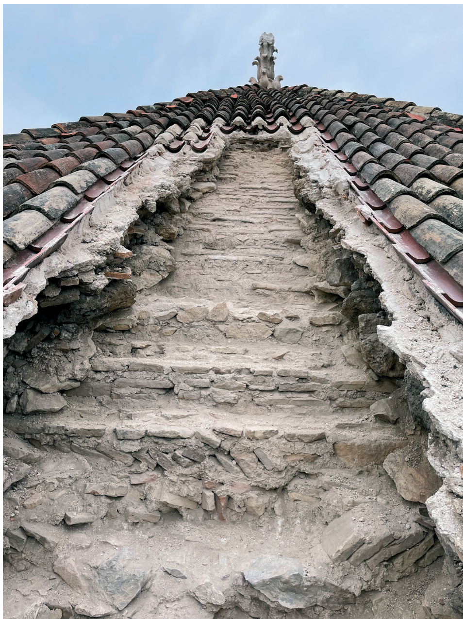
Sonda sjevernog dijela krova mauzoleja
