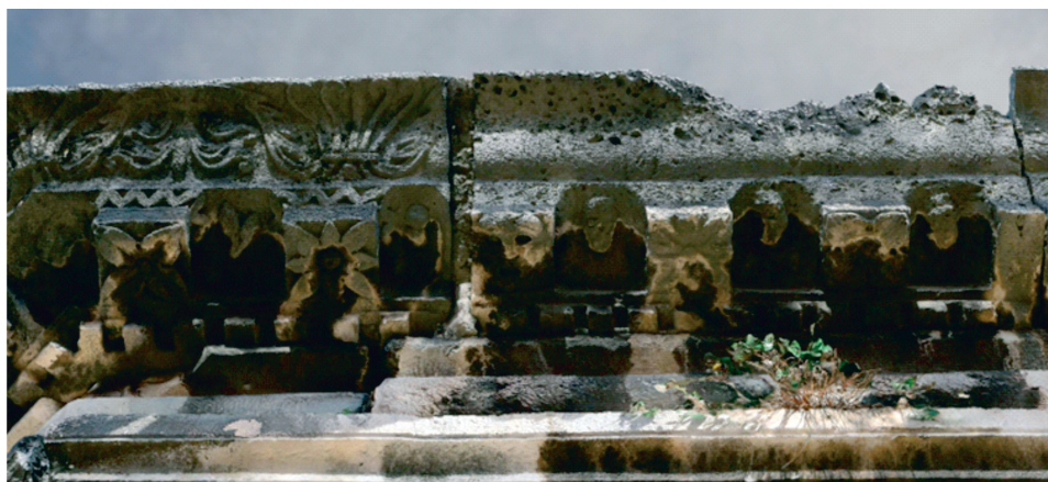
Detalj vijenca trabeacije in situ
