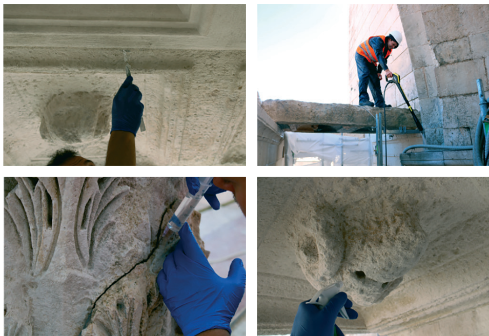
Radovi čišćenja, mikroinjektiranja i konsolidacije
