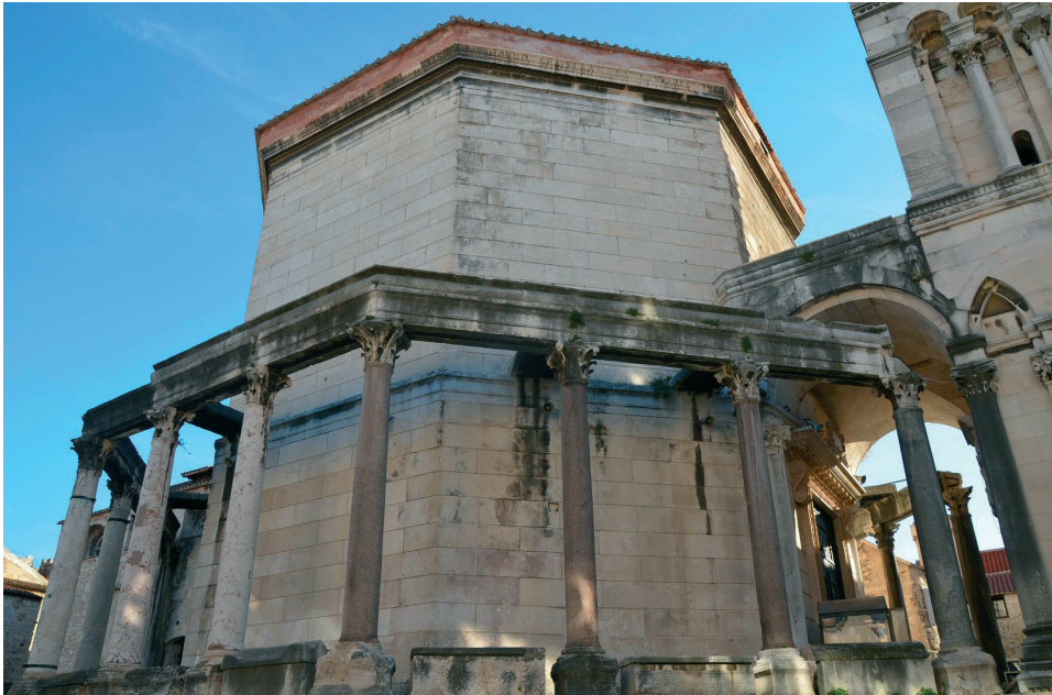
Sjeverna strana periptera Dioklecijanova mauzoleja prije radova
