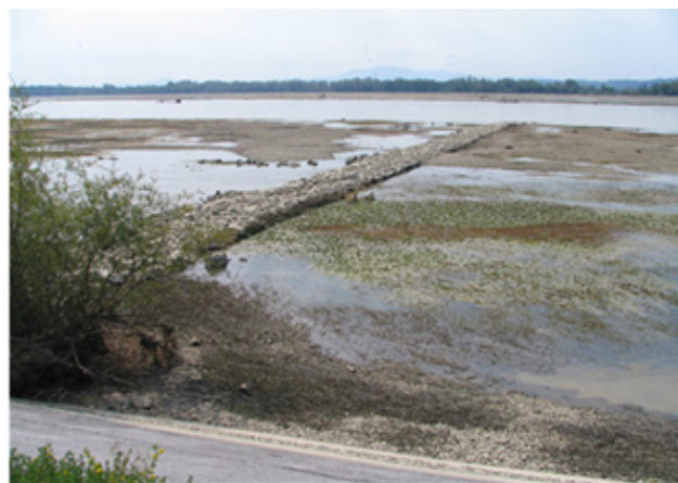
Slika 2. Izvedeno pero i istaloženi nanos unutar akumulacije HE Varaždin [3]
