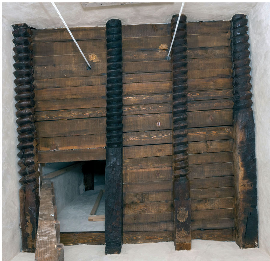
Sl. 11 Unutrašnjost zvonika, međukatna konstrukcija s gredama turnjačnice (Arhiv Hrvatskog restauratorskog zavoda)
