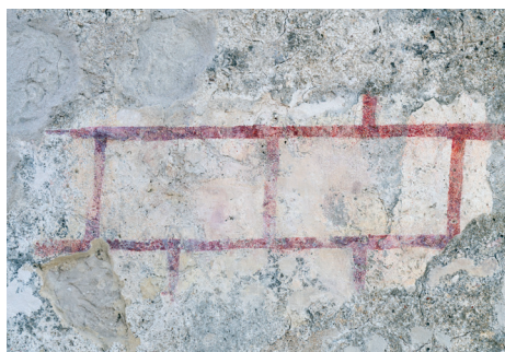
Sl. 10 Oslík na zvoniku s motivom crvenih sljubnica (Arhiv Hrvatskog restauratorskog zavoda)
