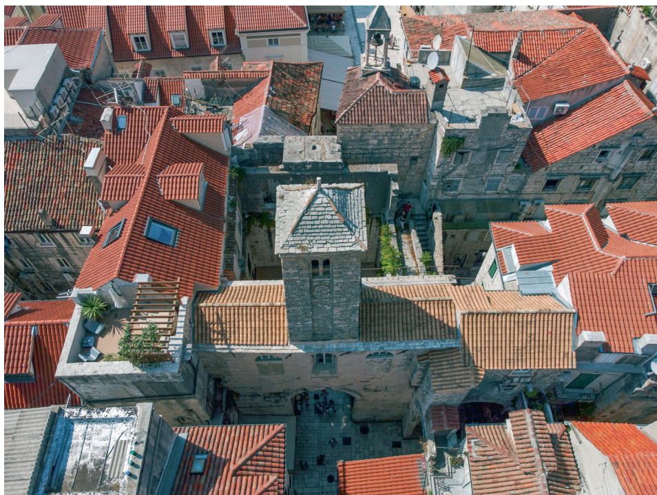
Sl. 1 Pogled na arhitektonski sklop Zapadnih vrata i crkve Gospe od Zvonika (Arhiv Hrvatskog restauratorskog zavoda)
