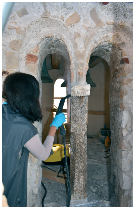
Sl. 9 Čišćenje bifora na zvoniku (Arhiv Hrvatskog restauratorskog zavoda)
