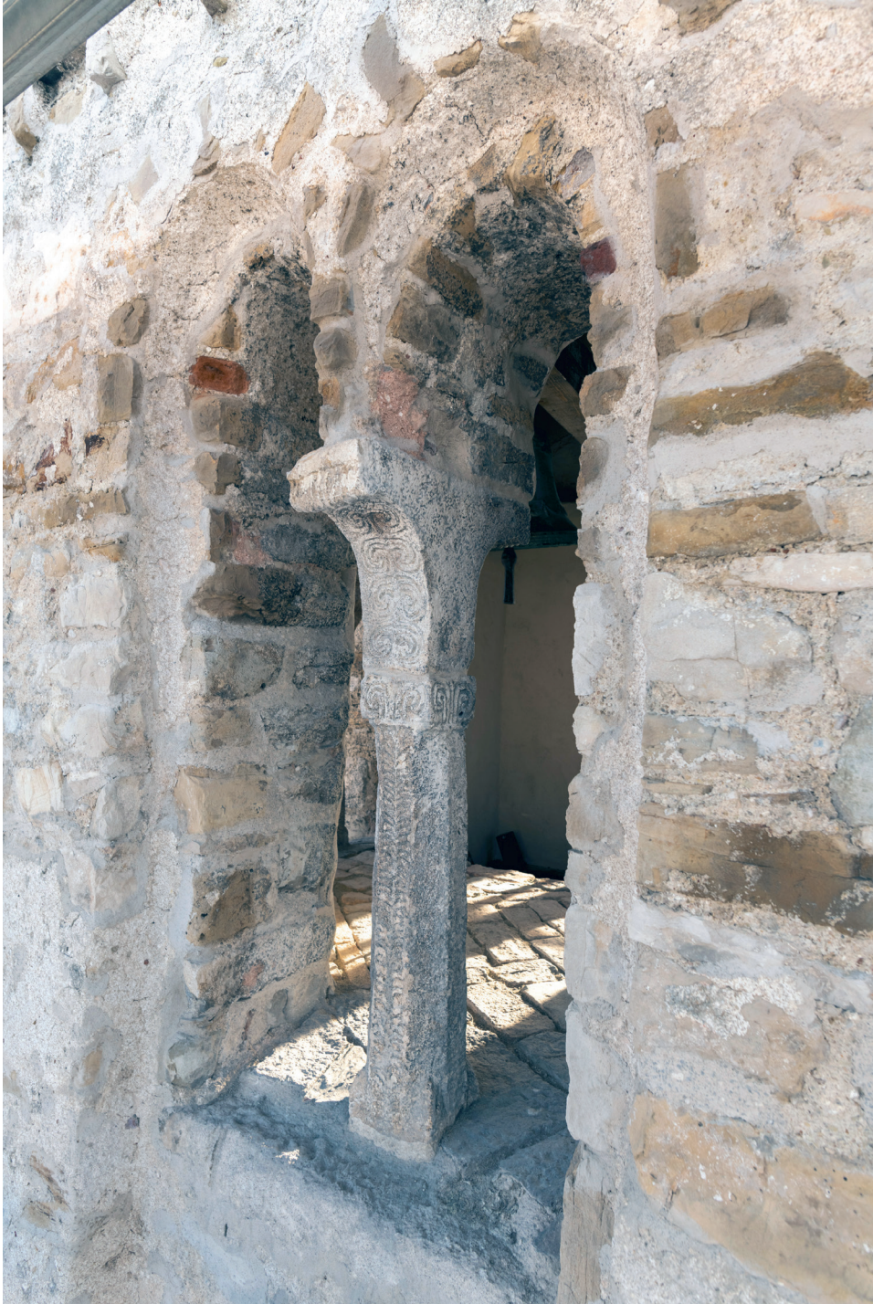
Sl. 8 Bifore na zvoniku (Arhiv Hrvatskog restauratorskog zavoda)
