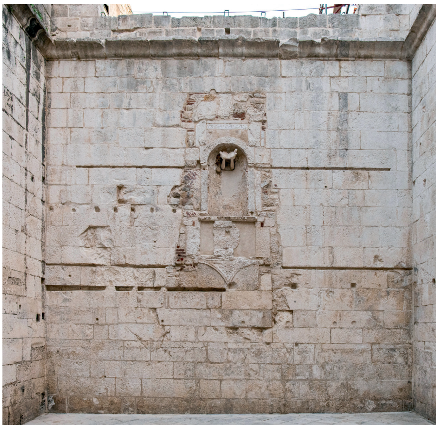
Sl. 6 Sjeverni unutrašnji zid propugnakuluma, stanje nakon konzervatorsko-restauratorskih radova (Arhiv Hrvatskog restauratorskog zavoda)
