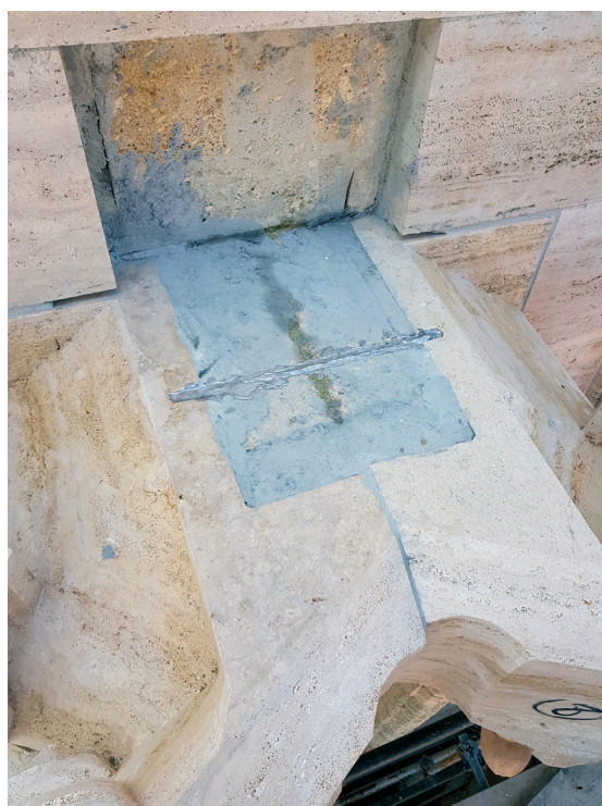
Slika 14. i 15. (dolje) Sidrenja inoks-sidrima \square 12 mm koja su zalijevana olovom (foto: D. Foretić) 4
