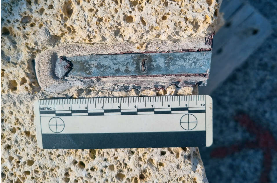
Slika 28. Dio horizontalne spone dvaju kamenih elemenata, sve zaliveno olovom (foto: D. Foretić, 2025.)
