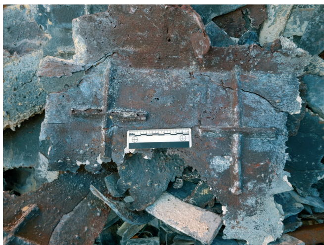
Slika 19. Postojeća olovna veza između kamenih elemenata na gornjoj poziciji (foto: D. Foretić)
