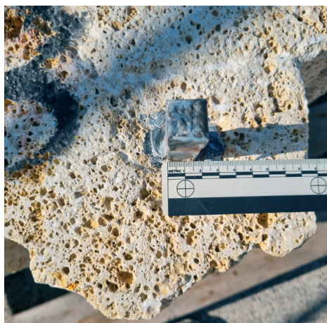
Slika 27. Detalj metalnog sidra u tlocrtu (foto: D. Foretić, 2025.)
