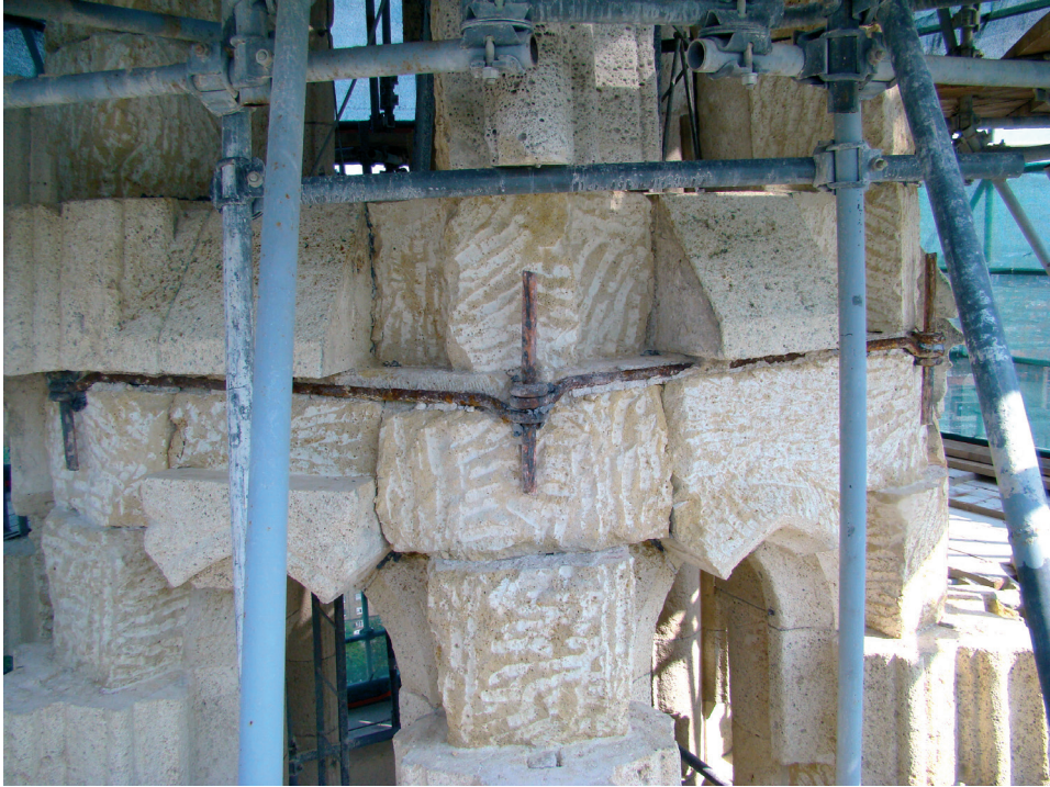
Slika 13. Originalni trnovi i prstenovi južnog tornja (foto: D. Foretić, 2012.) 3
