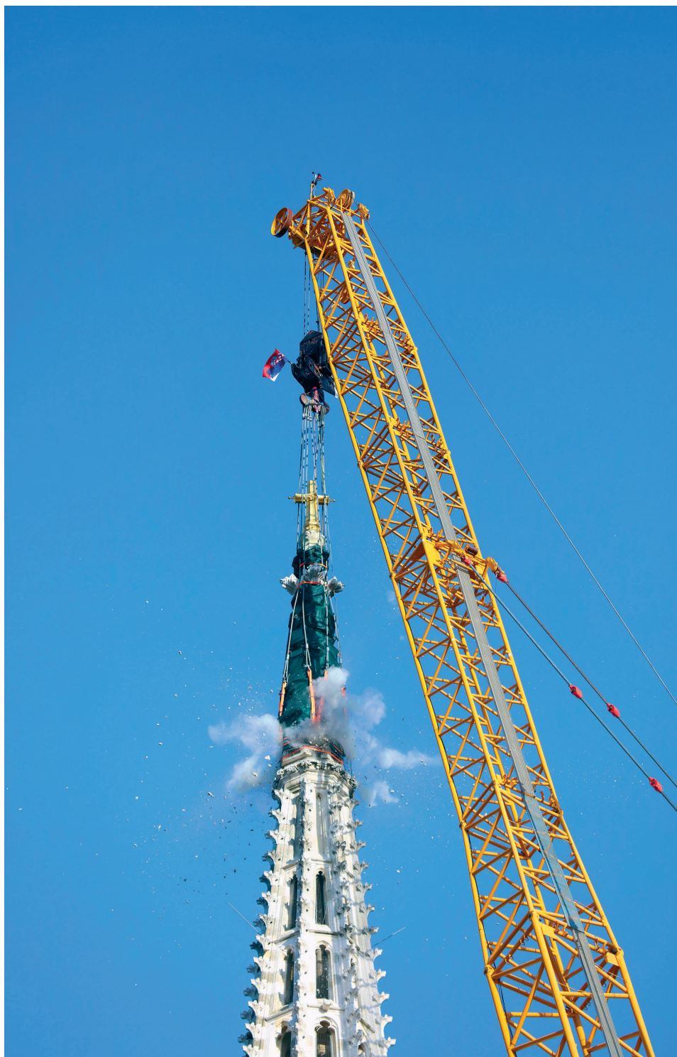
Slika 3. Kontrolirano miniranje 10 m vrha sjevernog tornja (foto: G. Vranić, 17. travnja 2020.)
