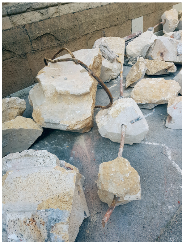
Slika 8. Ostatak vrha južnog zvonika gdje se vide željezni profili \square 35 mm (foto: D. Foretić, 23. ožujka 2020.)
