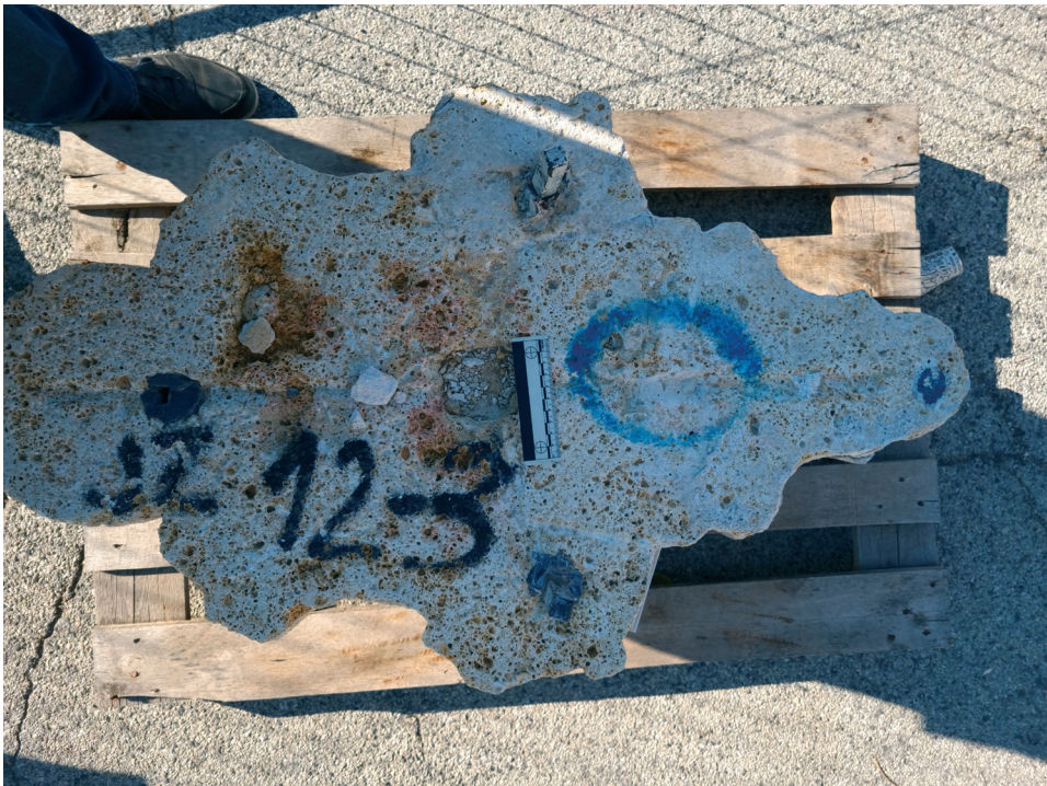
Slika 29. Raspored trnova unutar jednog kamenog profila na mjestu otvora. Vide se tri metalna kratka trna i kameni kojun (foto: D. Foretić, 2025.)
