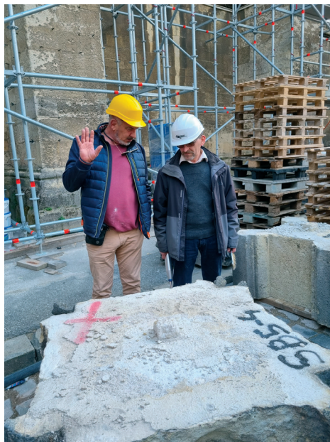
Slika 25. Kameni kojun kao protuklizni element spoja dvaju redova (foto: D. Foretić, 2023.)
