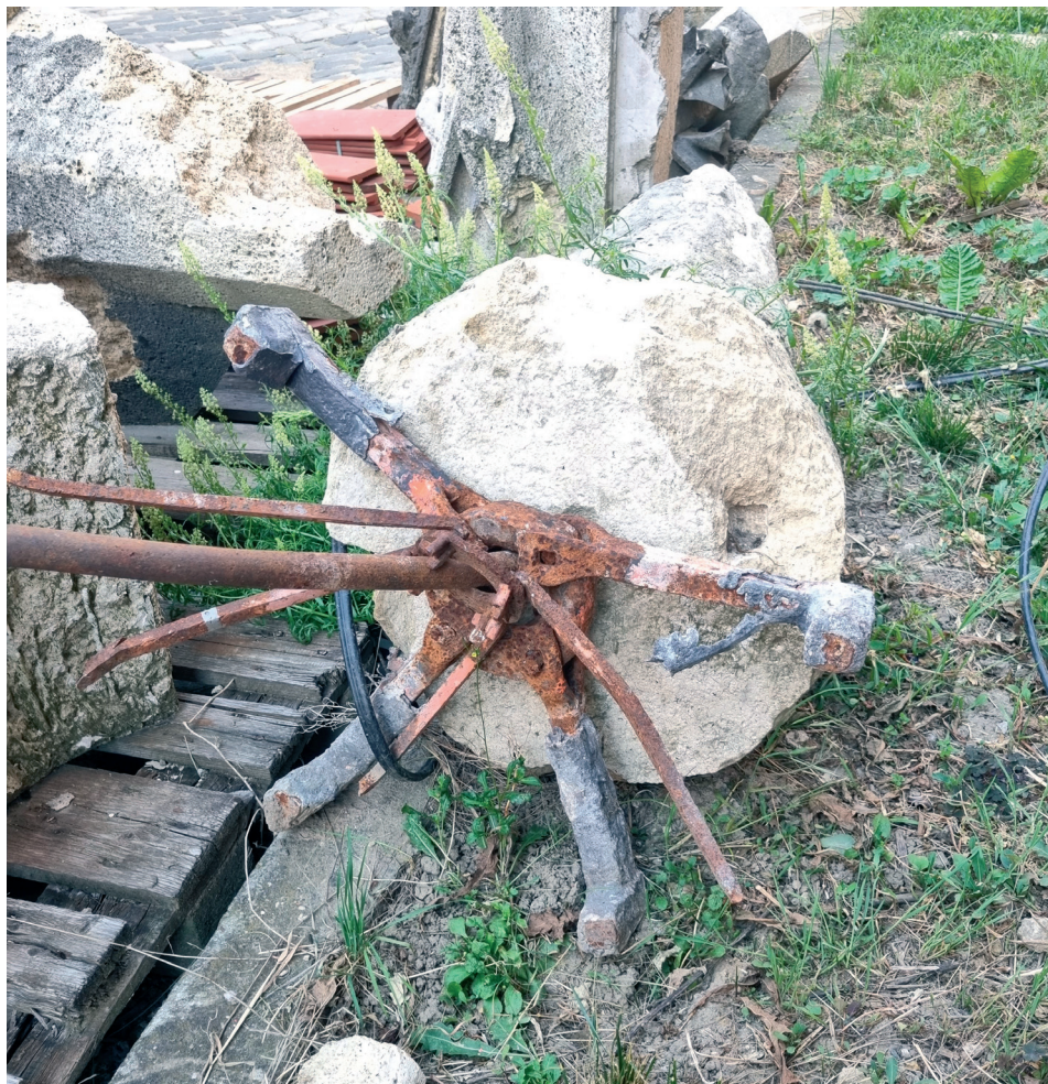
Slika 30. Vidi se način sidrenja kamenih elemenata na mjestu vrha južnog kamenog stubišta. Željezne sponje zalivene su olovom, a kroz sredinu prolazi okrugli profil na čijem je kraju visio protutupeg (foto: D. Foretić, 2021.)
