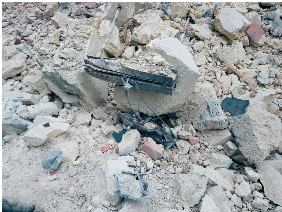
Slika 8. Ostatak vrha južnog zvonika gdje se vide željezni profili \square 35 mm (foto: D. Foretić, 23. ožujka 2020.)
