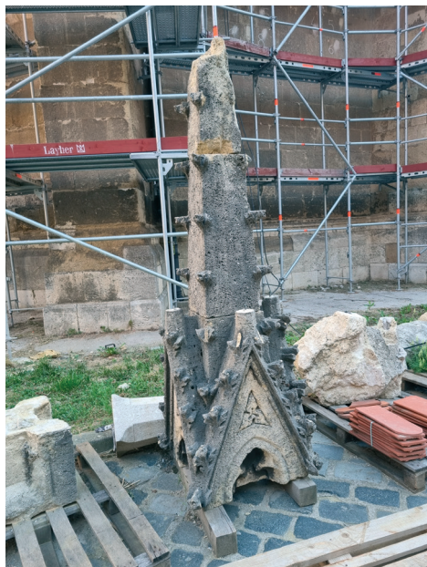
Slika 24. Demontirani vrhovi baldahina u jednom komadu s jednog od sjevernih kontrafora (foto: D. Foretić, 2022.)
