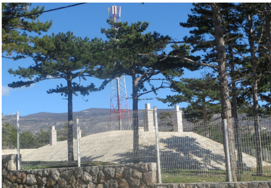
Stara vodosprema Sopaljska , sagrađena u prvoj fazi vodovoda, koristi se i danas i ograđena je žičanom ogradom. Snimio: Duško Katnić
