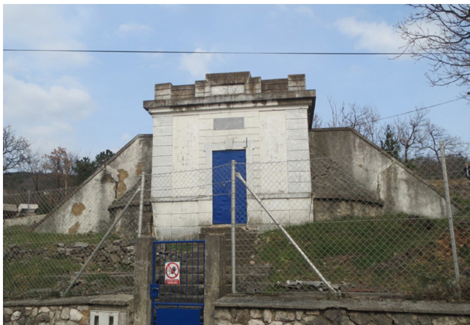
Pročelje vodospreme Therapia okrenuto cesti, na kojem stoji ploča s 1929. godinom. Vodosprema je morala postojati još u vrijeme kada je hotel Therapia izgrađen (1895.) jer je bila podignuta upravo za potrebe hotela. Na vrhu vodospreme vidljivo je prazno mjesto na kojem se vjerojatno prvobitno nalazila ploča s godinom njene izgradnje. Može se pretpostaviti da je tijekom vremena ploča ispala iz ležišta i uništena. Snimio: Duško Katnić.
