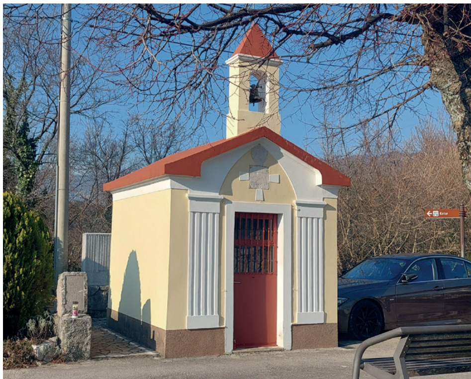
Kapelica nakon obnove izvedene 2008. godine. Snimila: Sanja Škrgatić.
